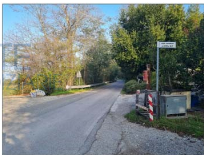
FOTO 01 - VIA GARAMPA LOCALITA' MONTERIALE
