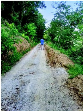
Foto 16: vista dal punto 17 verso sud.
