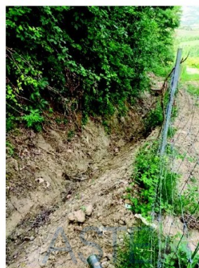
Foto 14: fosso di scolo a valle della scarpata.
