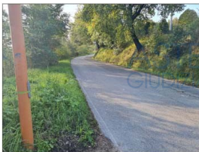
FOTO 02 - VIA GARAMPA LOCALITA' MONTERIALE
