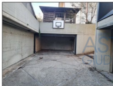
FOTO 20 - AUTORIMESSA NON CONFORME
