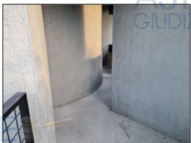
FOTO 22 - ACCESSO ALLE ABITAZIONI
