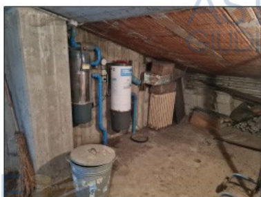
FOTO 43 - VANO COMUNE SOTTO RAMPA CARRABILE
