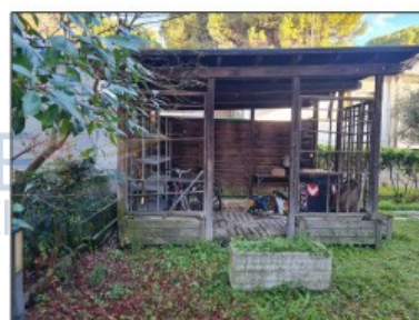
FOTO 29 - SISTEMAZIONE SU AUTORIMESSA NON CONFORME
