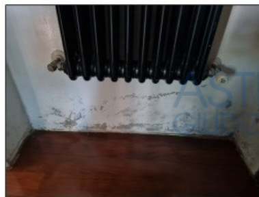
FOTO 108 - INFILTRAZIONE MURATURE
