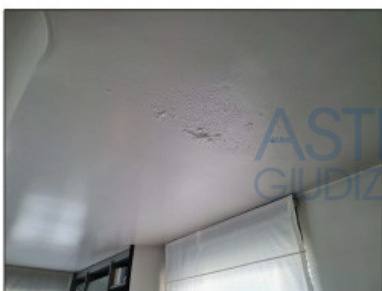
FOTO 113 - INFILTRAZIONE SOFFITTO
