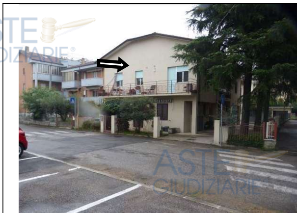
Foto 1, prospetto fronte strada, appartamento situato al primo piano
