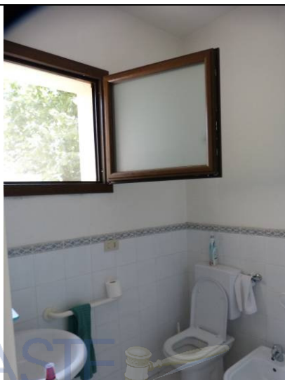
Foto 7, locale bagno al PT
