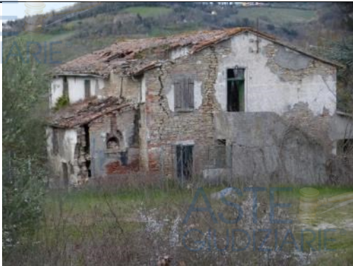
Prospetto Sud-Ovest dell'ex edificio colonico
