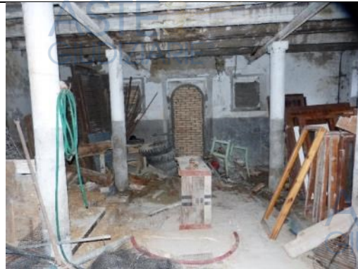
Interno – cantina/stalla al piano terra
