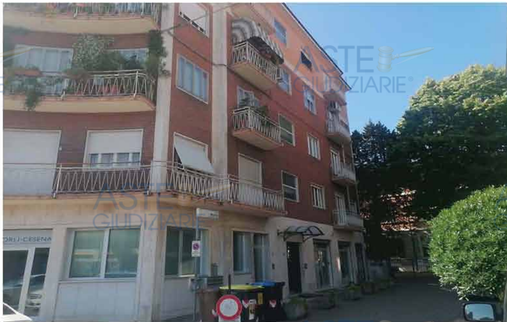
vista dell'immobile dal Viale Roma
