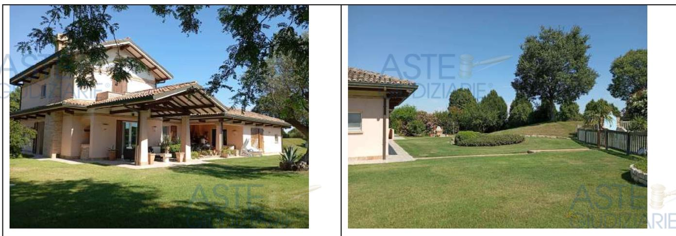
Esternamente il complesso edilizio si presenta intonacato e tinteggiato con finiture marcapiano in laterizio, manto di copertura in coppi, gronde e pluviali in rame e infissi in pvc a doppi vetri con scuroni lignei e, in generale, un ottimo livello di finiture.
