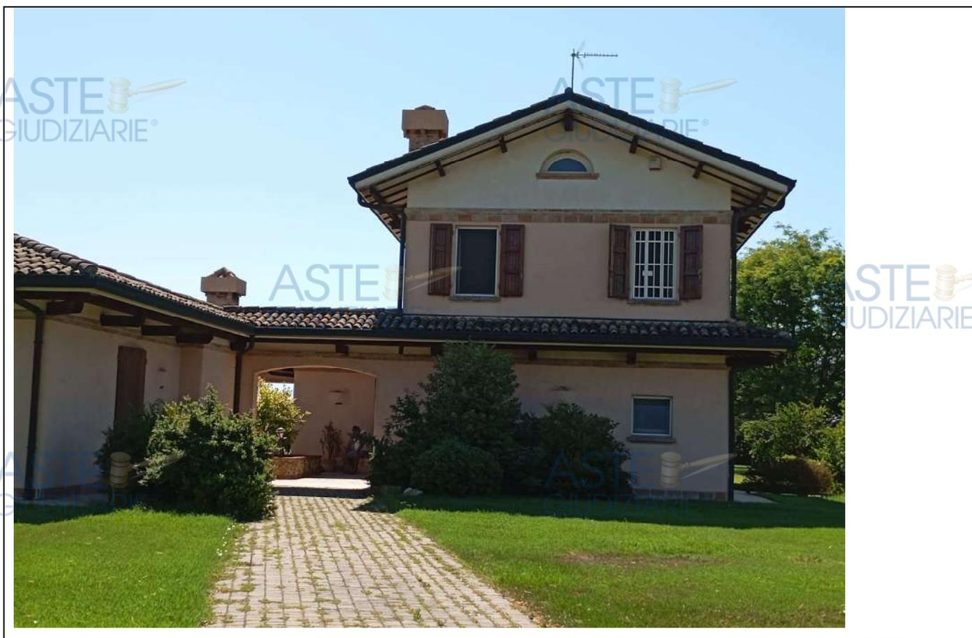
La struttura dell'edificio è costituita da telaio in conglomerato cementizio armato, solai in latero-cemento, tamponamenti in laterizio.
