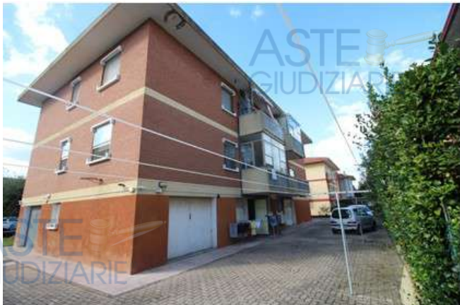
Foto 3: edificio condominiale – prospetto retro est
