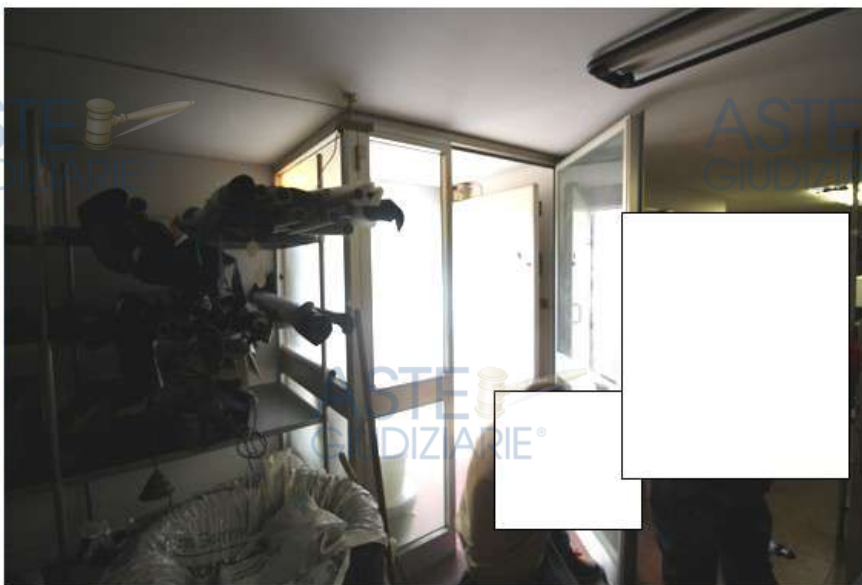
Foto 6: ingresso – vista dall'interno e dettaglio bussola
