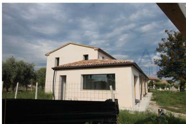
Foto 5: vista sul fabbricato – prospetto ovest
