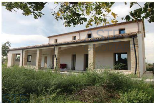
Foto 2: vista sul fabbricato – prospetto sud
