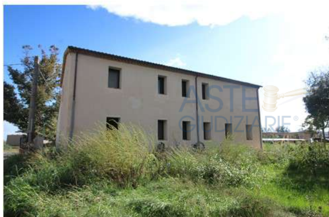
Foto 4: vista sul fabbricato – prospetto nord
