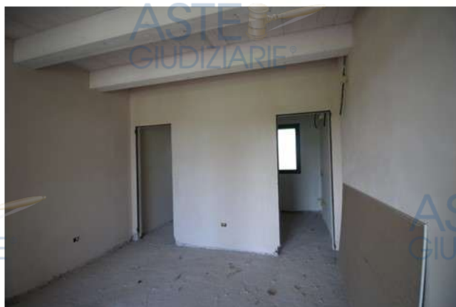
Foto 11: ingresso – vista verso bagno e lavanderia
