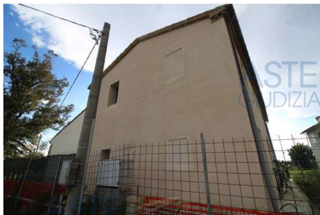
Foto 3: vista sul fabbricato – prospetto est
