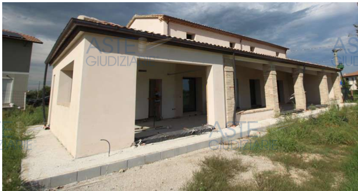
Foto 1: vista sul fabbricato – prospetti sud e ovest
