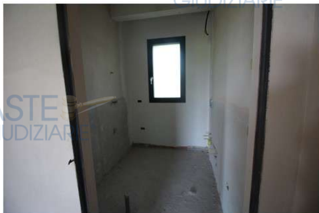
Foto 12: bagno piano terra
