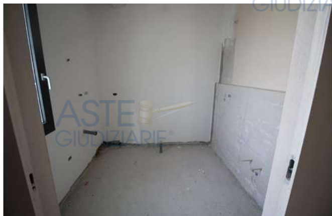
Foto 25: bagno al piano
