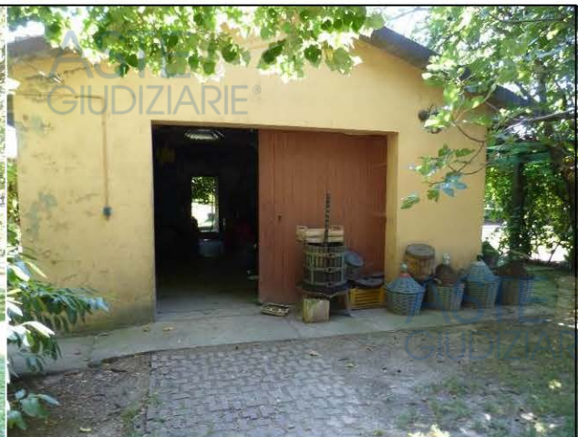
Vista esterna fabbricato attrezzaia
