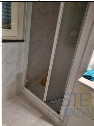
Foto 11, bagno wc- box doccia
