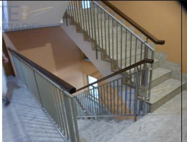
Foto 3, vano scale comune
