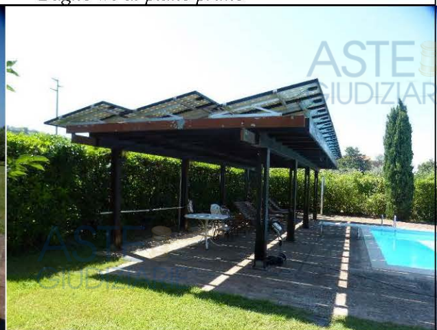
Pergolato + copertura in pannelli fotovoltaici
