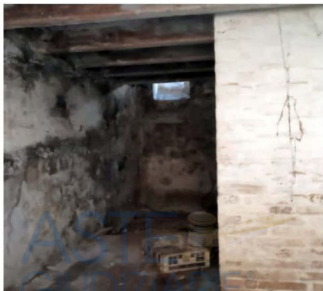
Cantina al piano interrato
