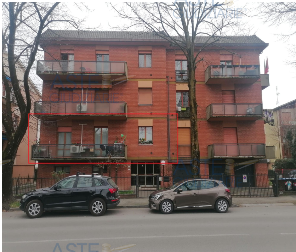
vista dell'immobile condominiale da Viale Fulcieri
