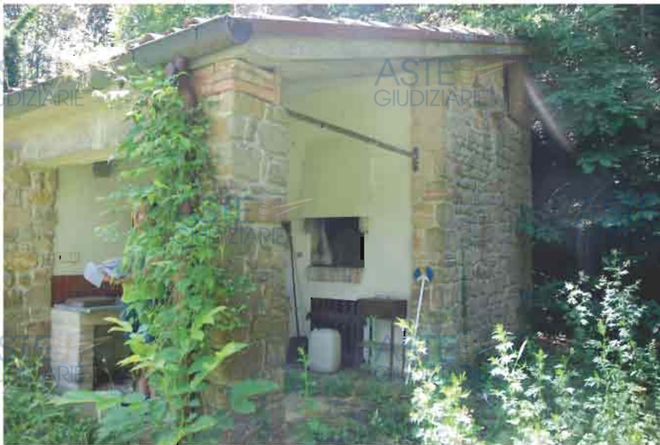
Fot. 18 Vista del proservizio. Dettaglio del piccolo portico.
