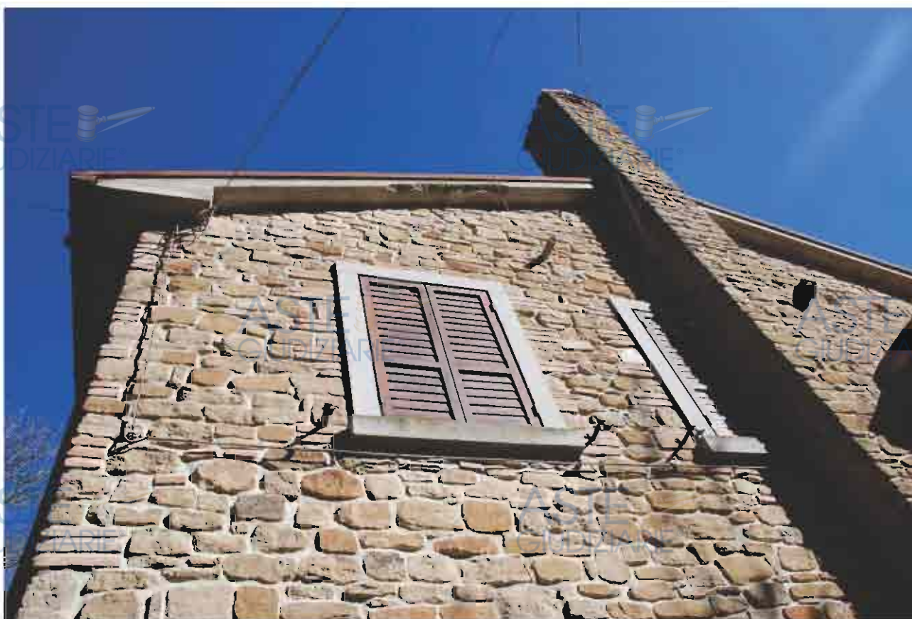
Fot.4 Dettaglio della facciata del villino.
