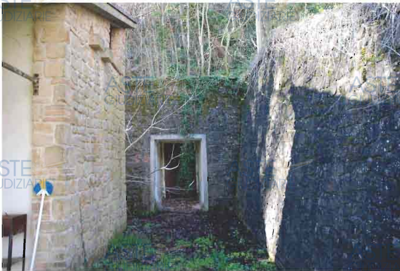
Fot. 25 Vista dell'accesso della cantina .
