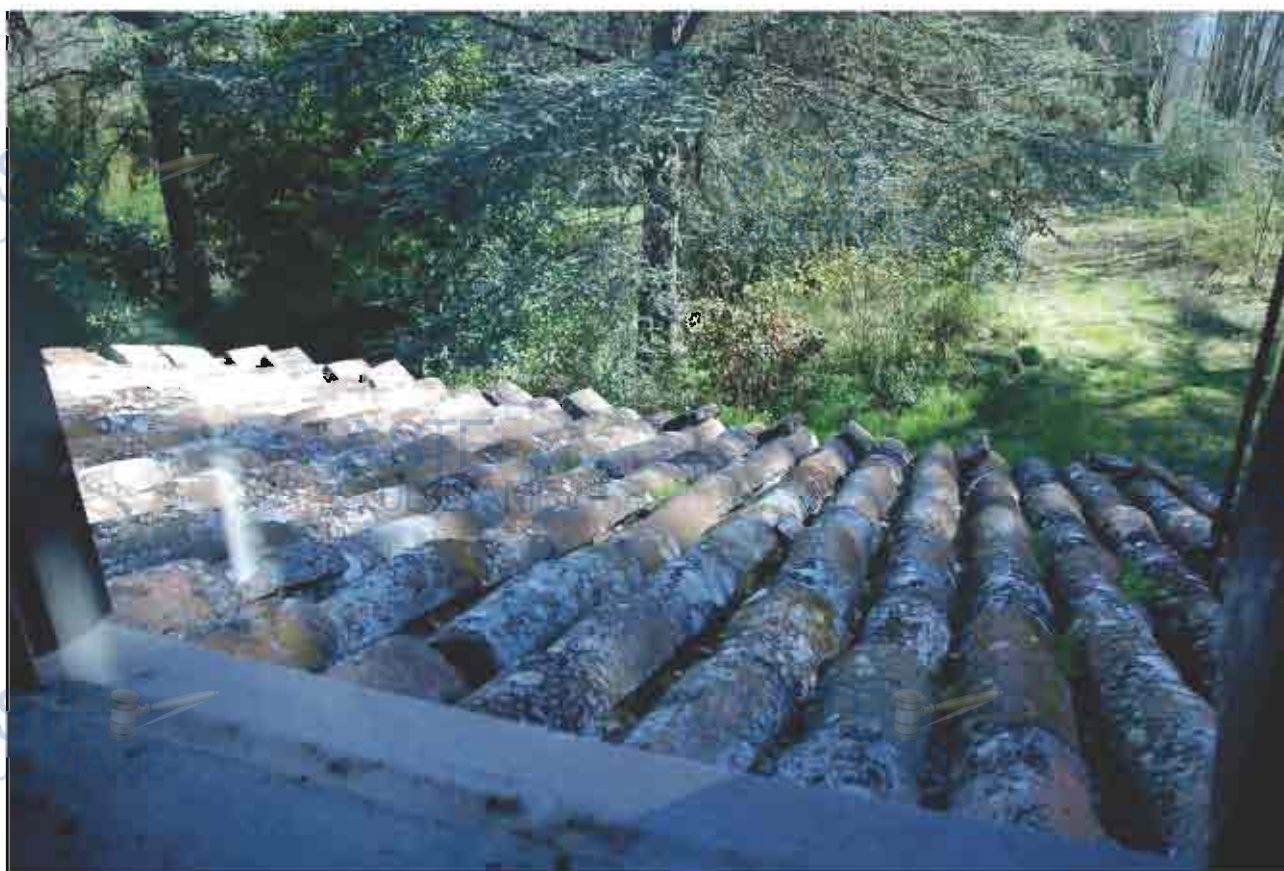
Fot.12 – manto di copertura del porticato.
