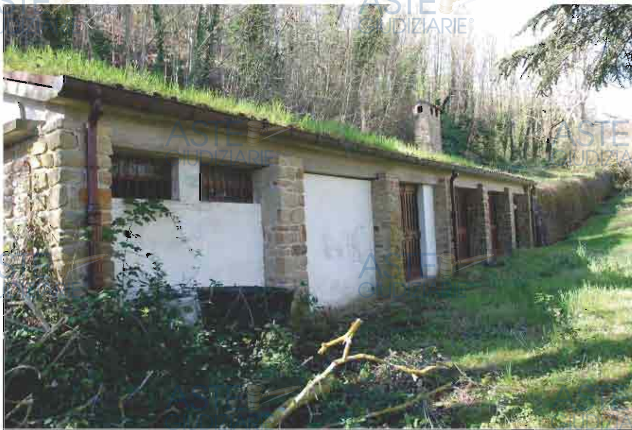
Fot. 17 Vista del proservizio.
