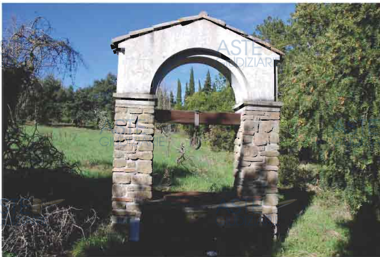
Fot. 30 - Pozzo artificiale all'interno del parco.
