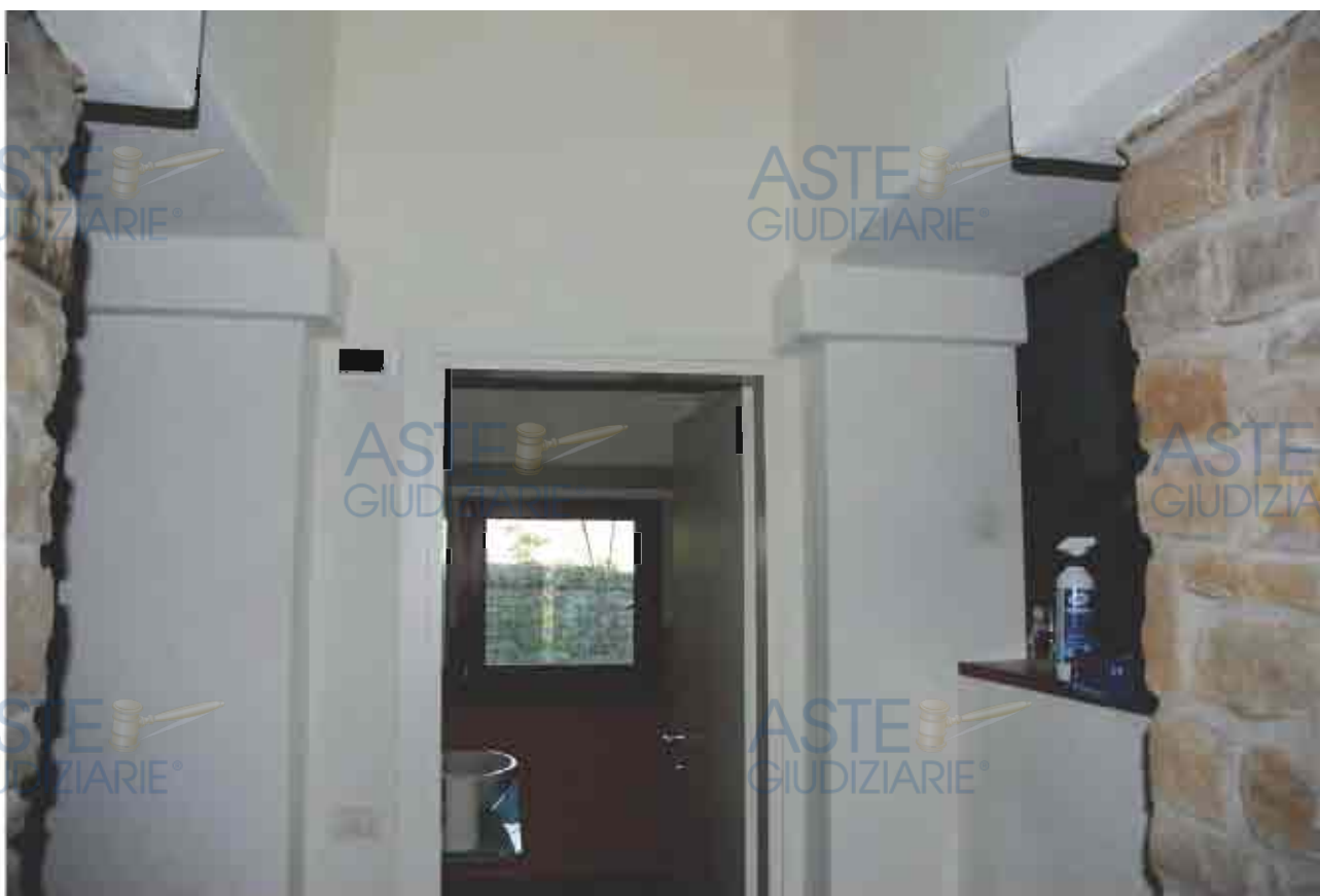
Fot.8 Ingresso servizi igienici al piano terra.
