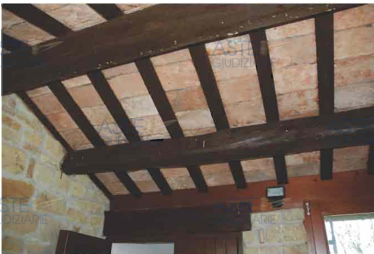
Fot.15 -16 Dettagli esecutivi del soffitto di copertura
