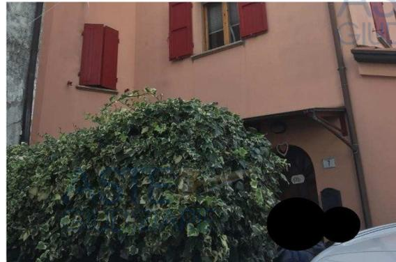
La struttura del fabbricato è di tipo misto. Esternamente si presenta intonacato e tinteggiato con la presenza di macchie di muffa sulla tinteggiatura esterna.
