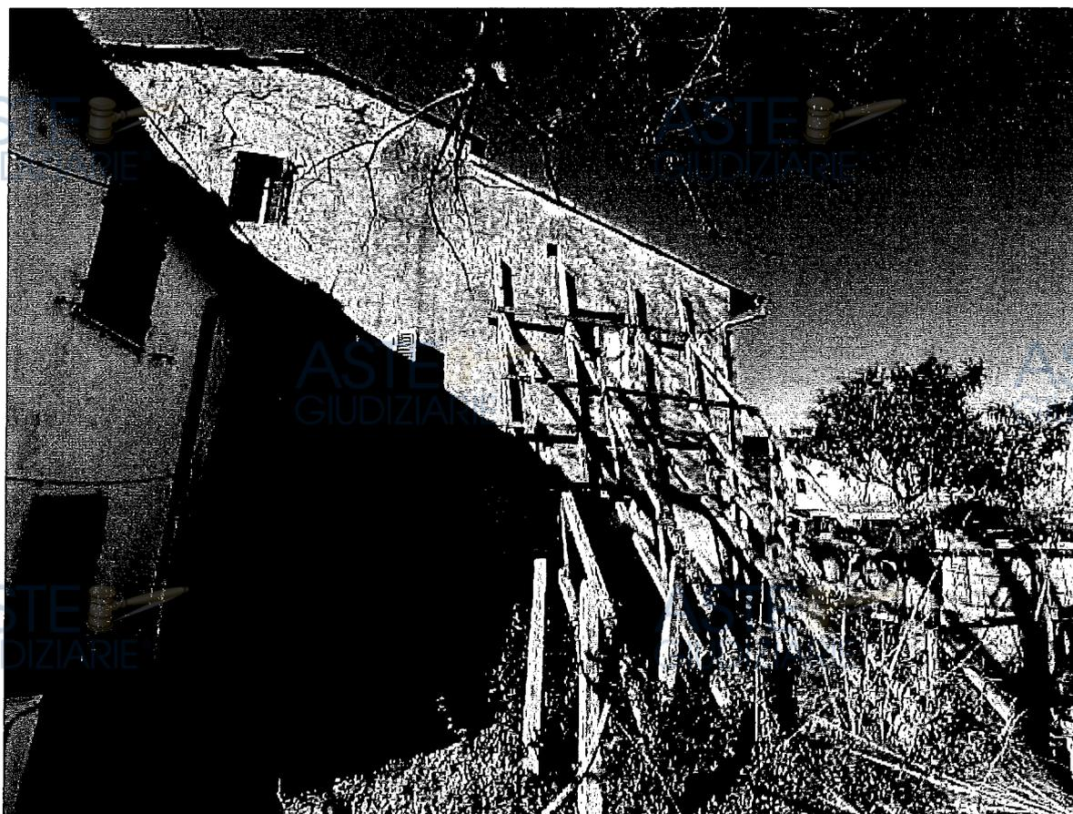
Foto n. 6 – Prospetto laterale con puntellatura di ritegno
