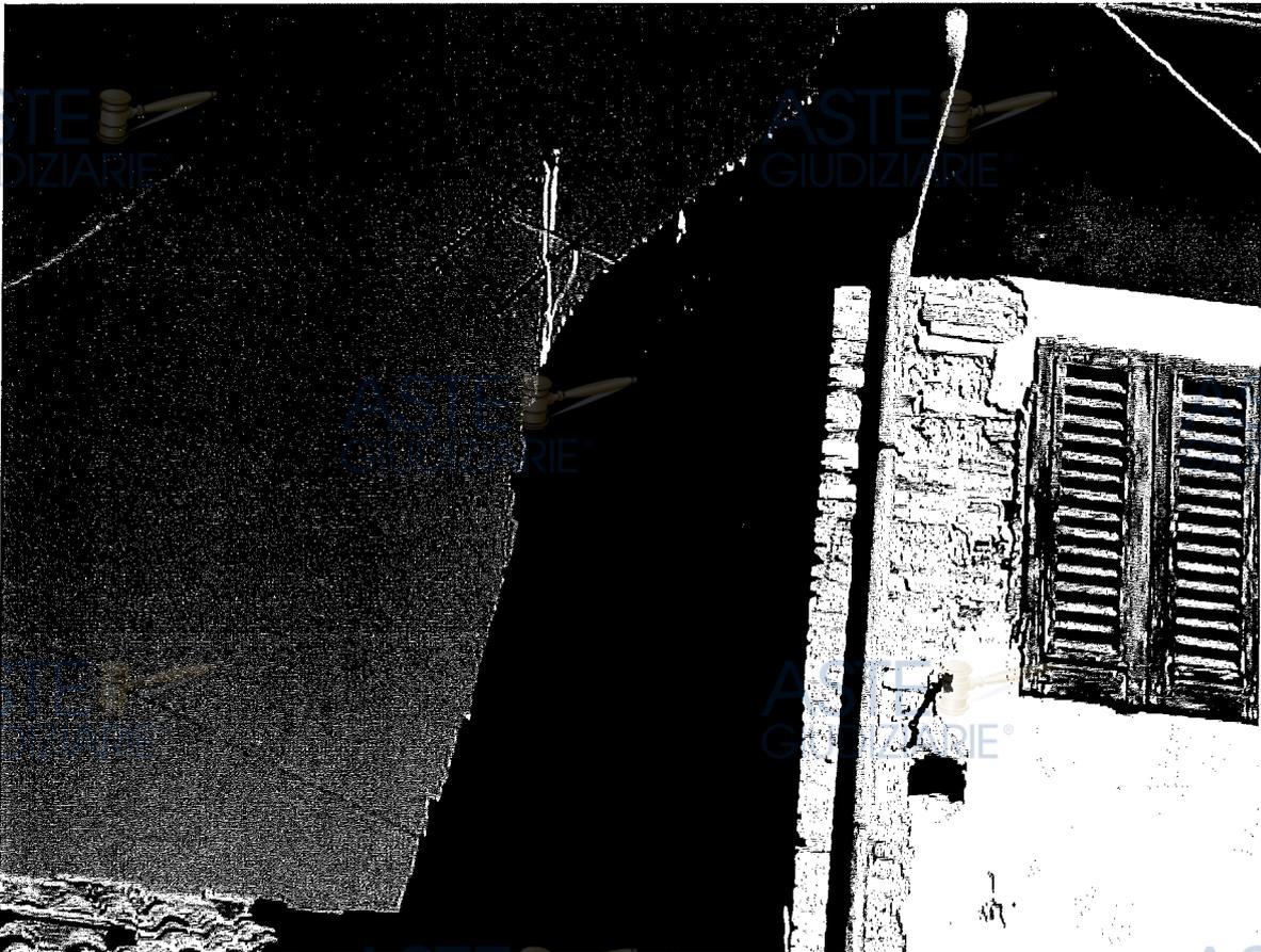
Foto n. 10 – Prospetto laterale su altra proprietà con crollo della copertura
