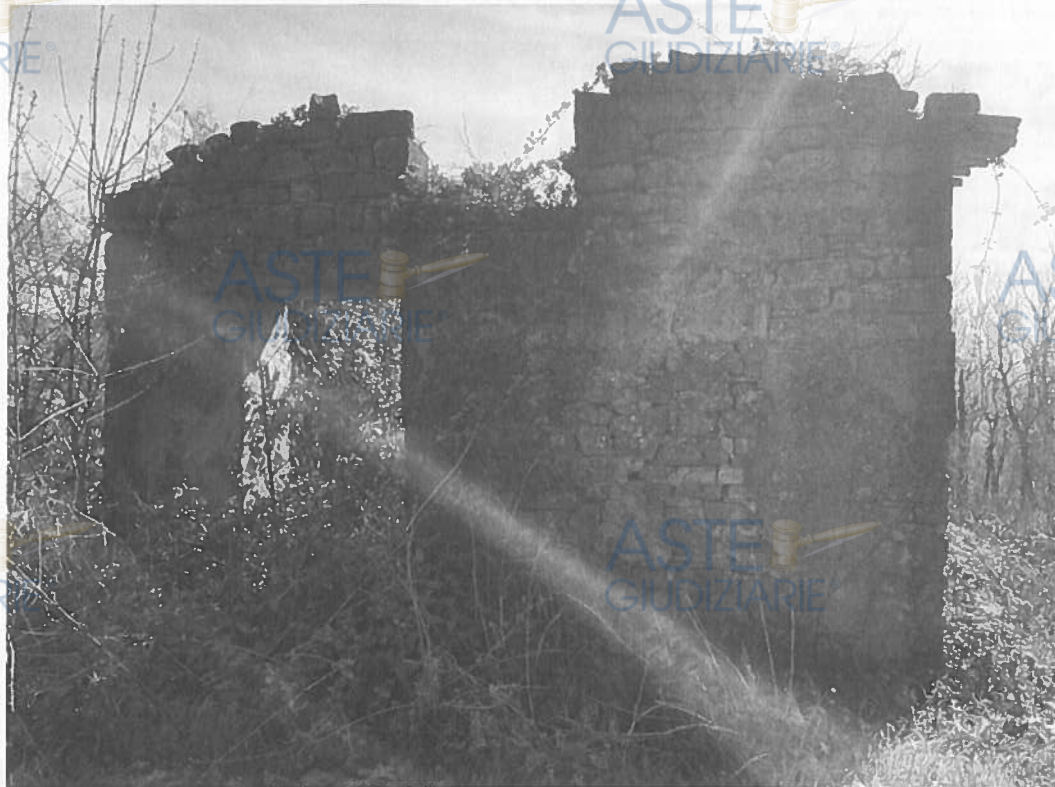
Foto 3) Lato Ovest – Parete del rudere lato strada
