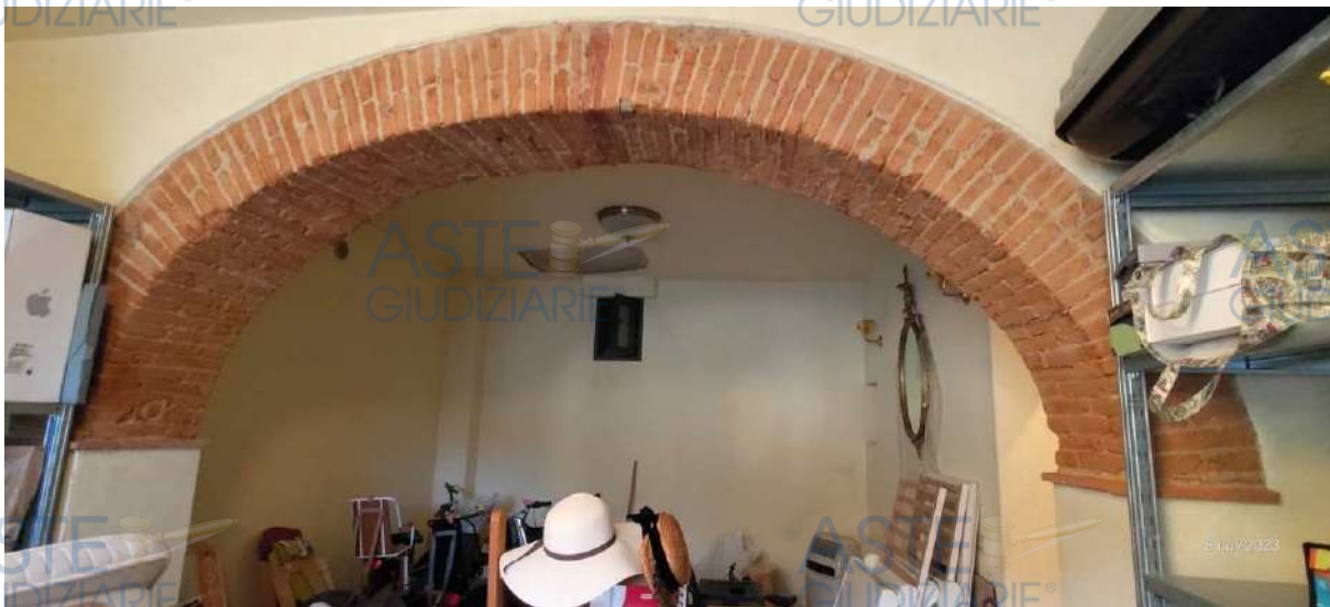
Foto 6 – particolare fondo da ingresso
