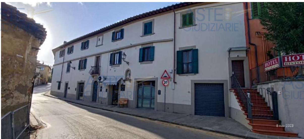
Figura 3 – Particolare immobile da via Jacopo Modesti
