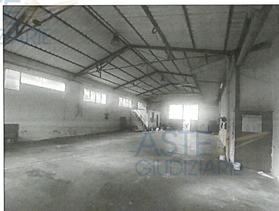
9- Il fabbricato internamente
