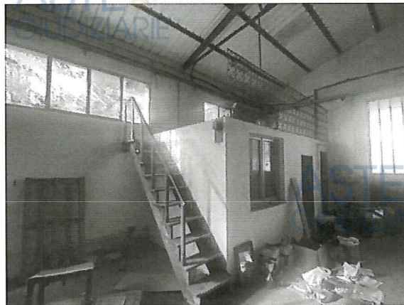
8- Il fabbricato internamente con zona uffici e servizio
