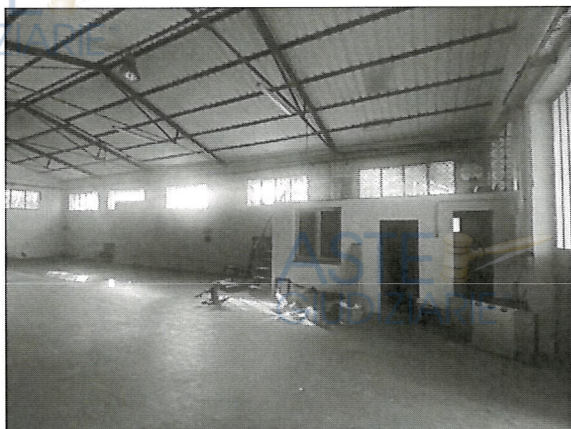
7- Il fabbricato internamente
