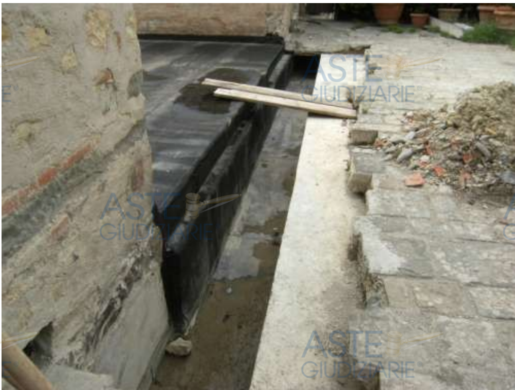
PIAZZALE ESTERNO DAVANTI AGLI UFFICI
