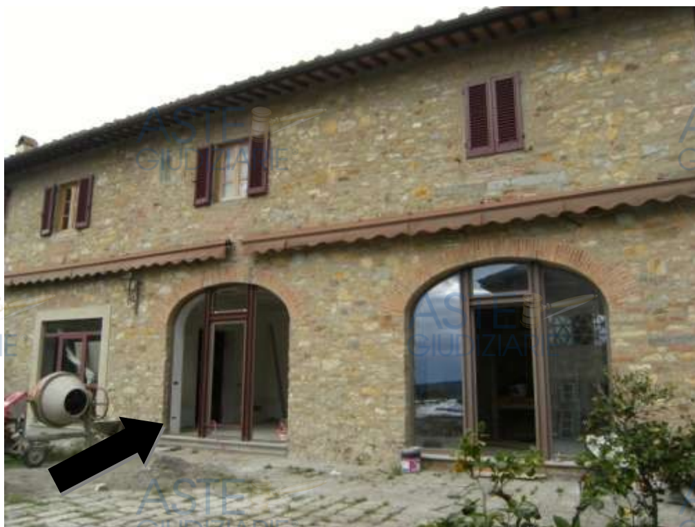
FACCIATA UFFICI (RIPRISTINO APERTURA)
