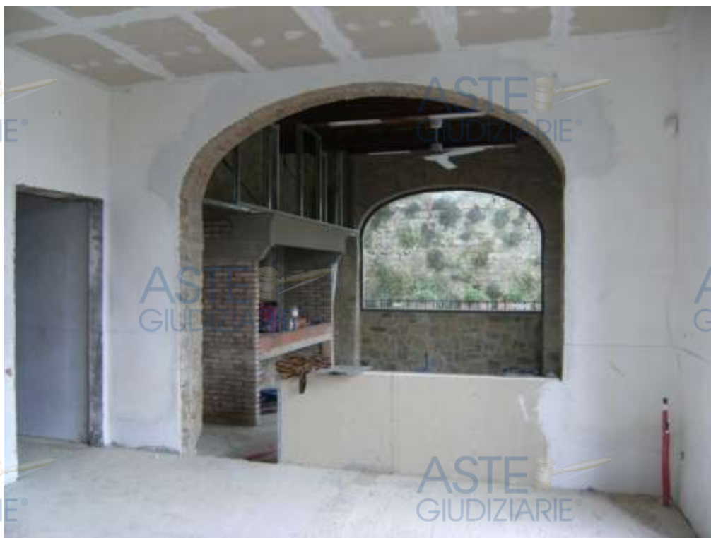
DEMOLIZIONE DI PORZIONE DI TRAMEZZO
