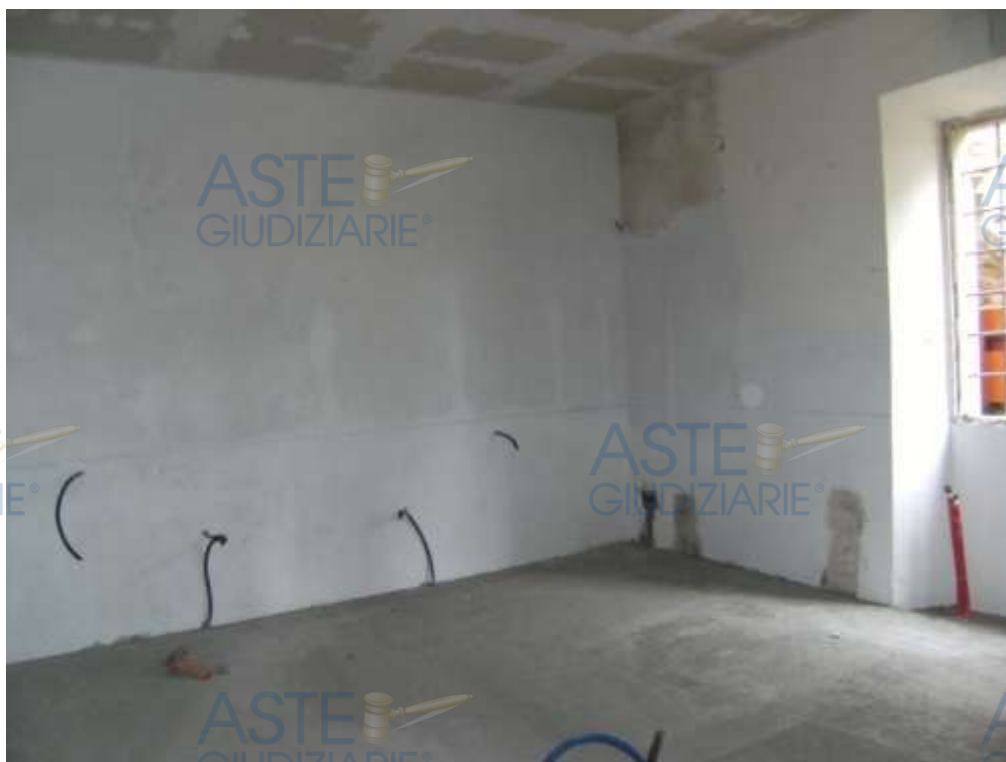
DEMOLIZIONE TRAMEZZI INGRESSO E W.C.
