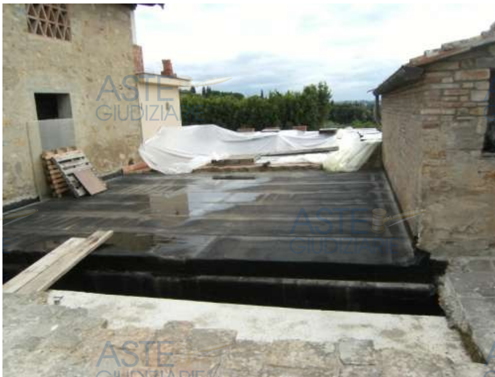
PIAZZALE ESTERNO DAVANTI AGLI UFFICI
