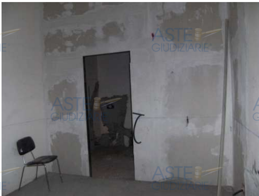
COSTRUZIONE TRAMEZZO NUOVO BAGNO
