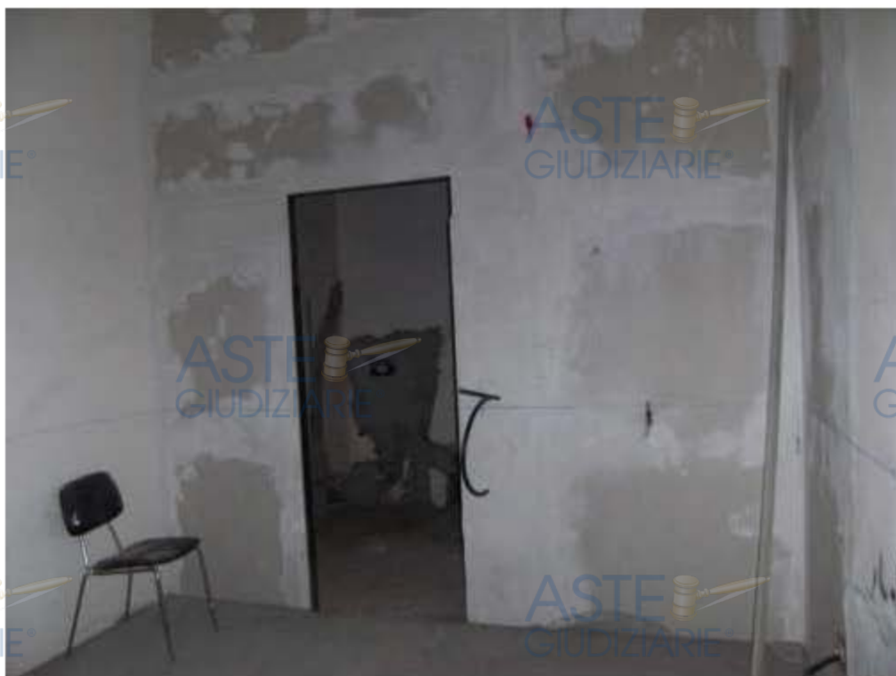
COSTRUZIONE TRAMEZZO NUOVO BAGNO
