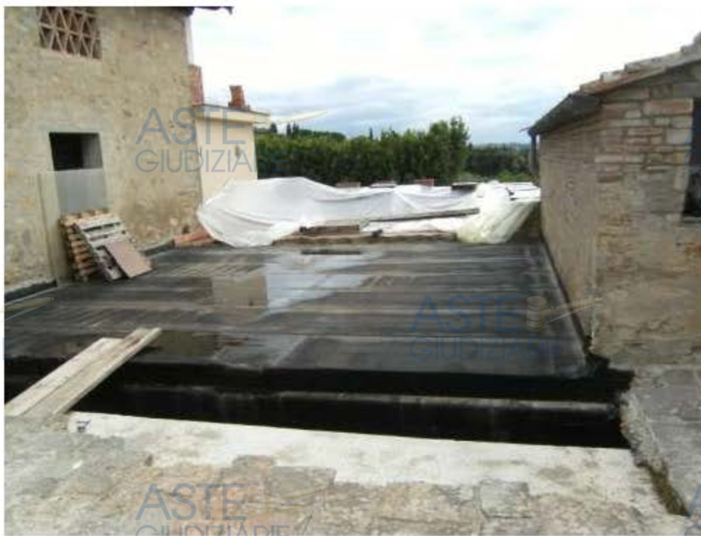
PIAZZALE ESTERNO DAVANTI AGLI UFFICI
