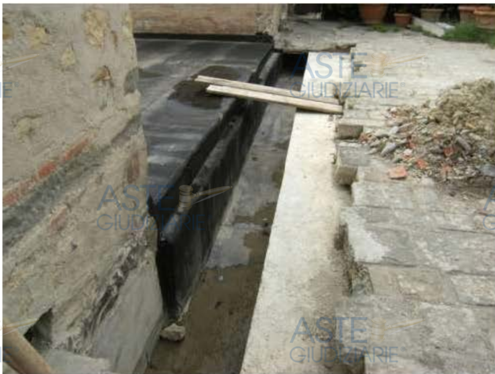
PIAZZALE ESTERNO DAVANTI AGLI UFFICI
