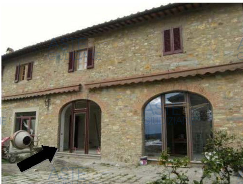
FACCIATA UFFICI (RIPRISTINO APERTURA)
