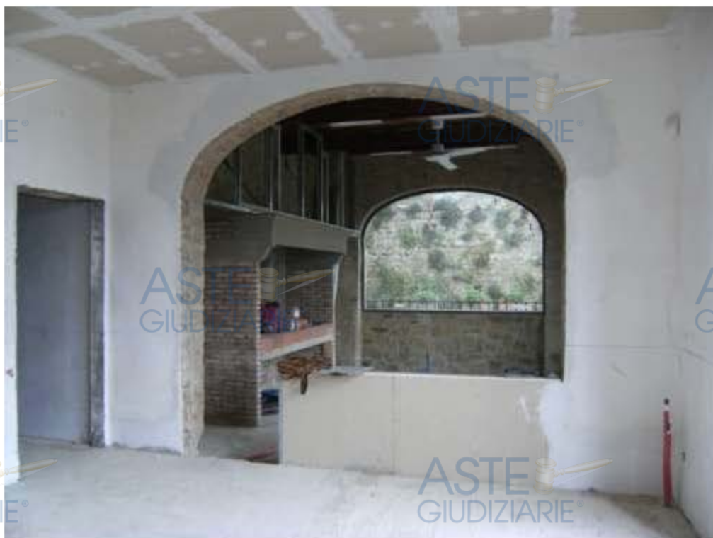
DEMOLIZIONE DI PORZIONE DI TRAMEZZO
