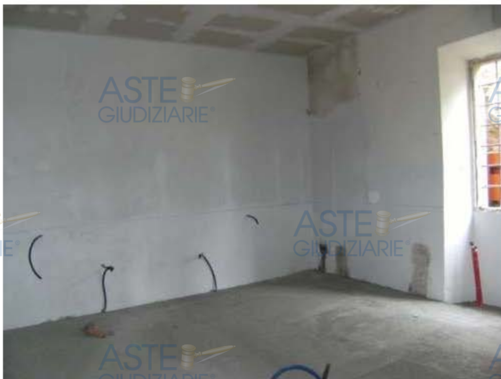
DEMOLIZIONE TRAMEZZI INGRESSO E W.C.
