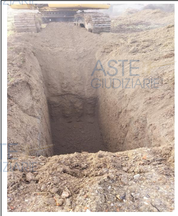
Esecuzione degli scavi per i prelievi di materiale in profondità
