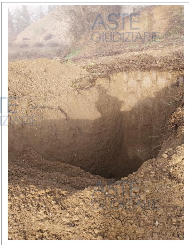
Scavi per il prelievo dei materiali
