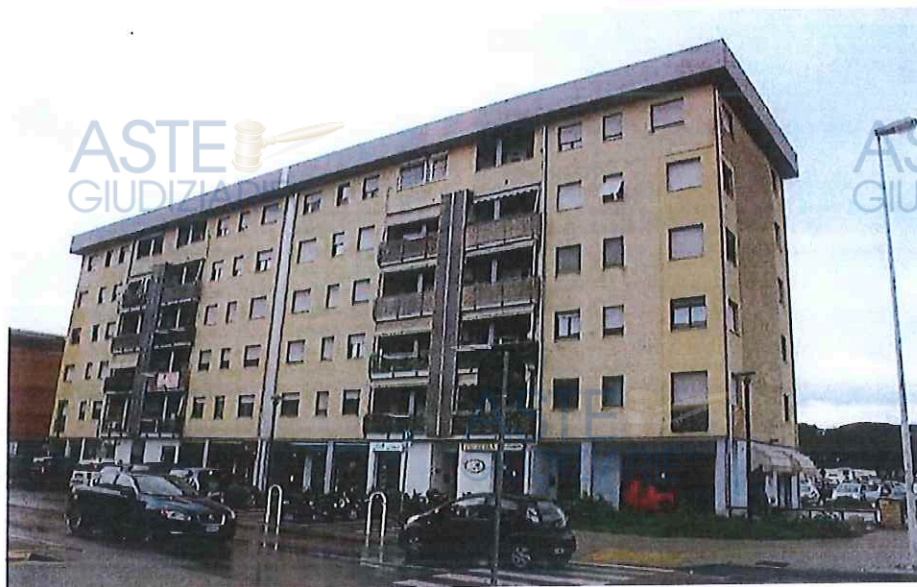
Foto 1) - Vista d'insieme dell'edificio da Via Ischia
