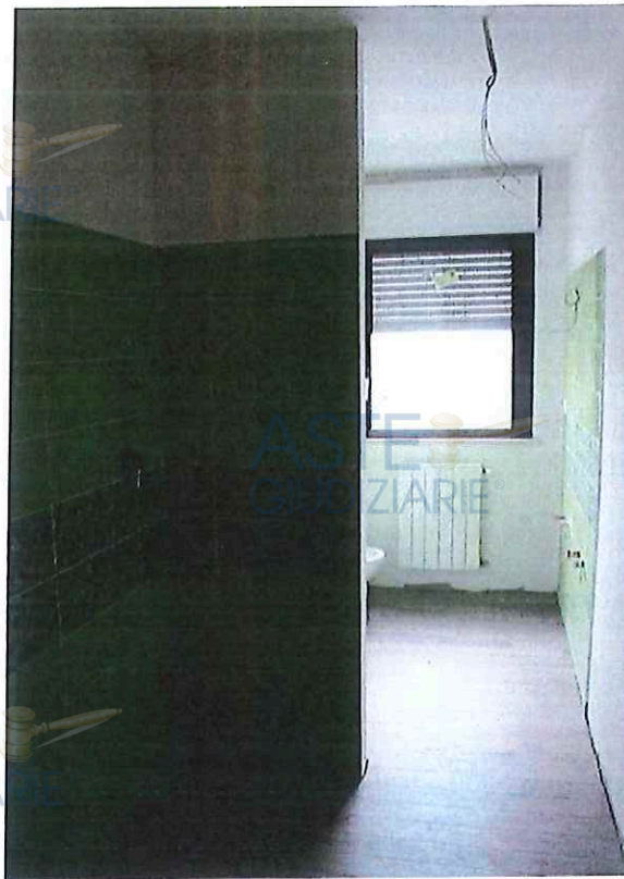
Foto 5) - Vista del servizio igienico
