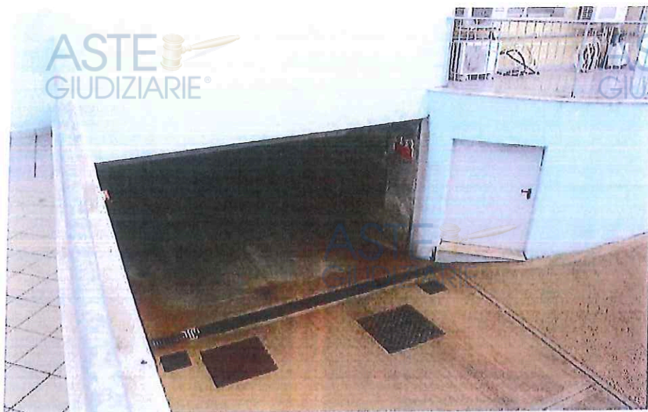
Foto 7) - Vista della rampa e dell'accesso ai box al piano seminterrato
