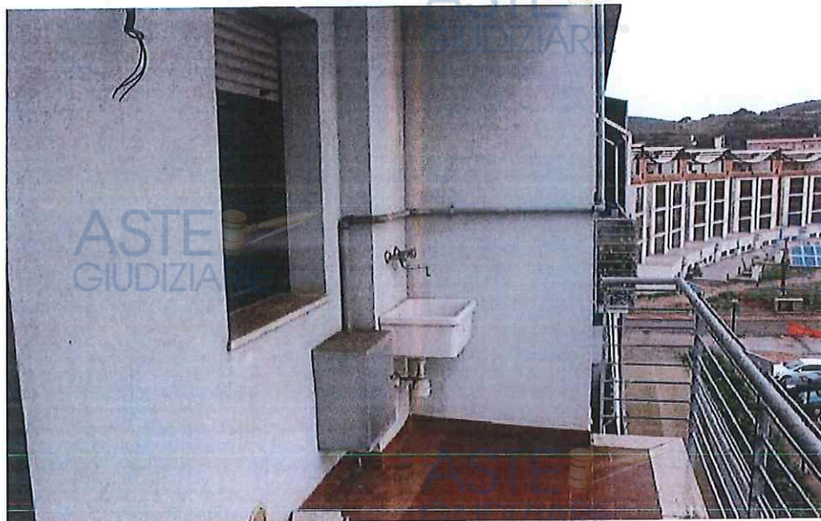
Foto 6) - Vista della terrazza
