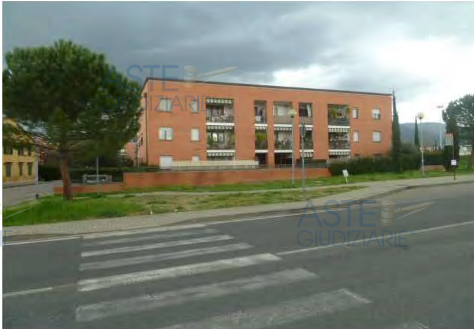
Foto 1 - Vista dell'edificio condominiale
