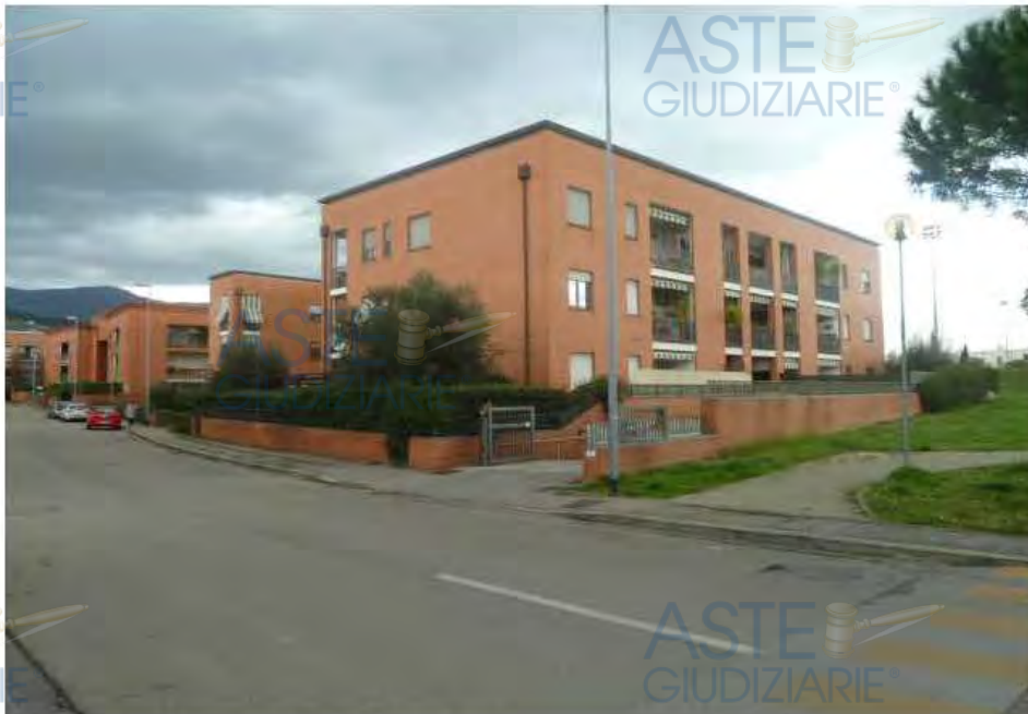
Foto 2 - Vista dell'edificio condominiale
