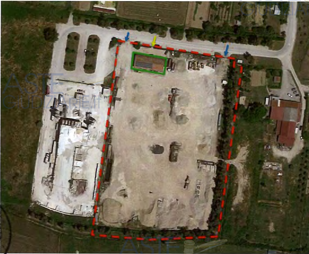
Fig. 2 – Complesso immobiliare oggetto di stima
