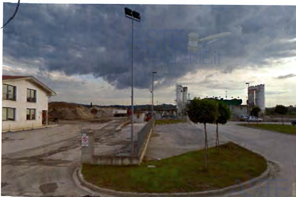
Fig. 11 – Vista dalla via Petroio
