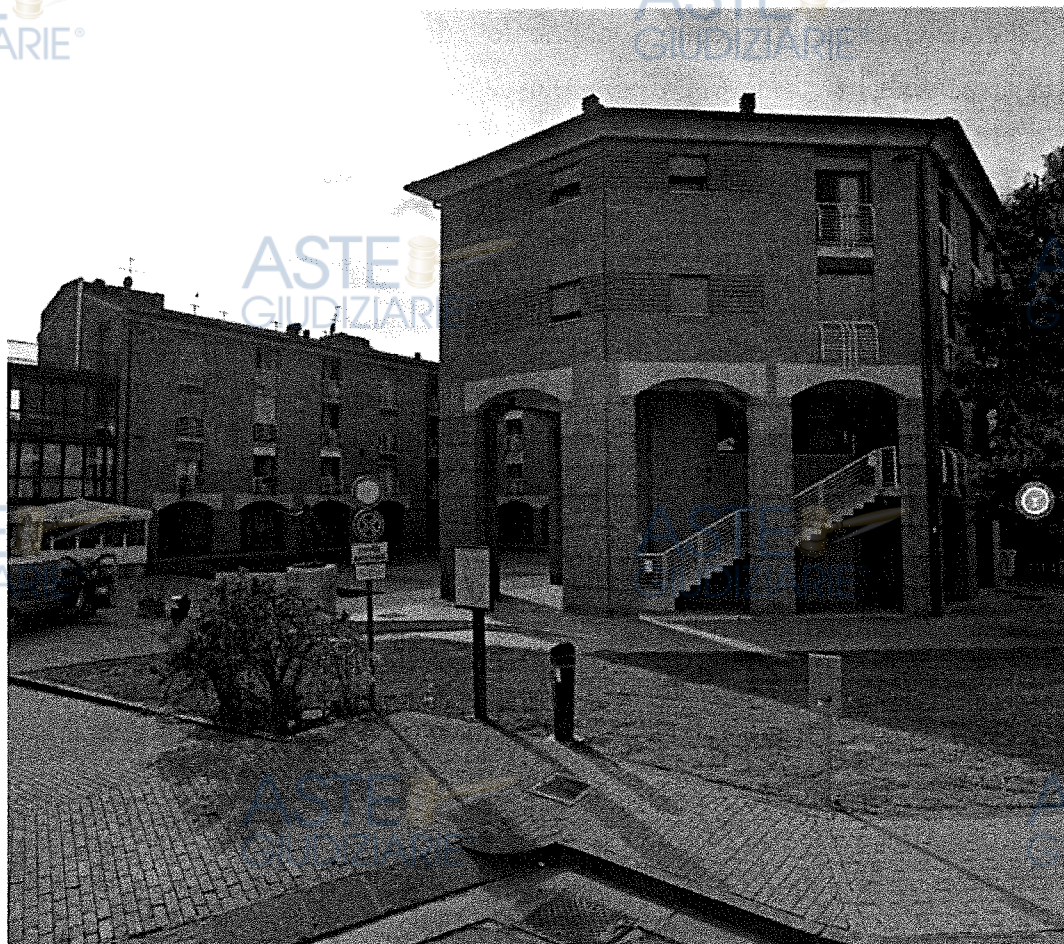
4. Illustrazione: fabbricato di tre piani fuori terra, fronte strada
