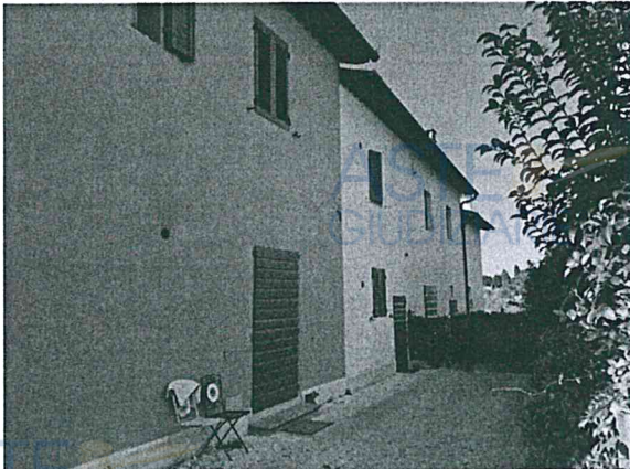
3- l'edificio lato di destra
