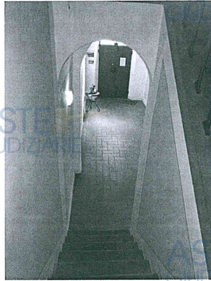
22- le scale di accesso al piano primo
