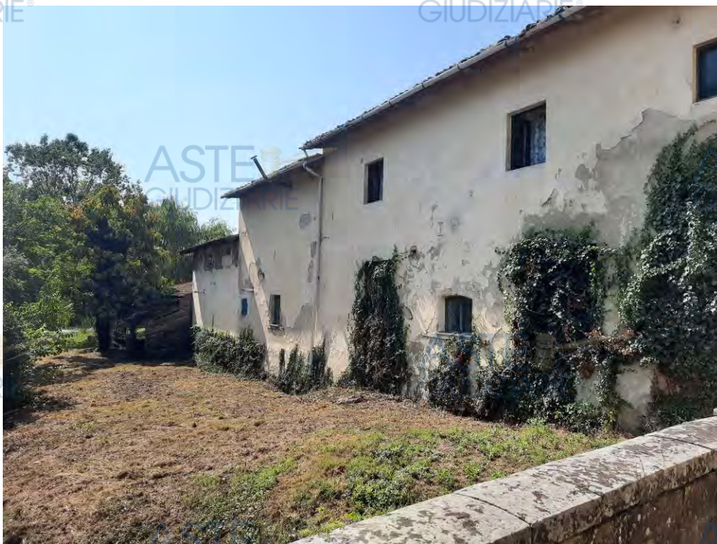
FOTO 11 – Prospetto retrostante del fabbricato ‘A’
