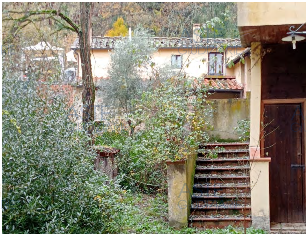
FOTO 22 – Secondo accesso all' appartamento da scala in muratura
