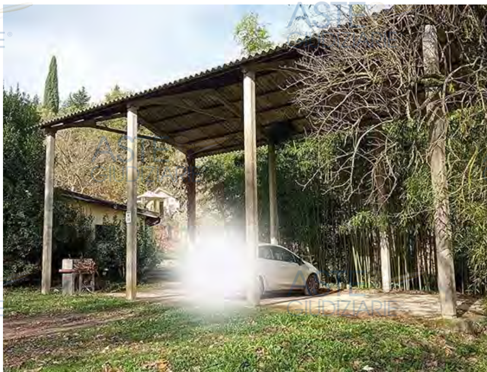
FOTO 47 – Tettoia per rimessa macchine e attrezzi
