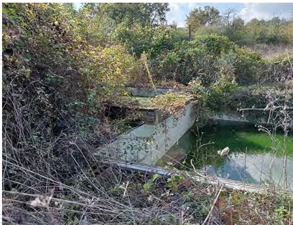
FOTO 54 – Altra immagine in prossimità del vano tecnico
