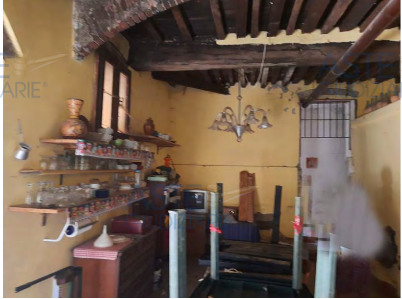
FOTO 35- Una delle cantine
