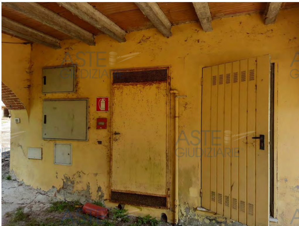
FOTO 26 – Accesso alla centrale termica a comune
