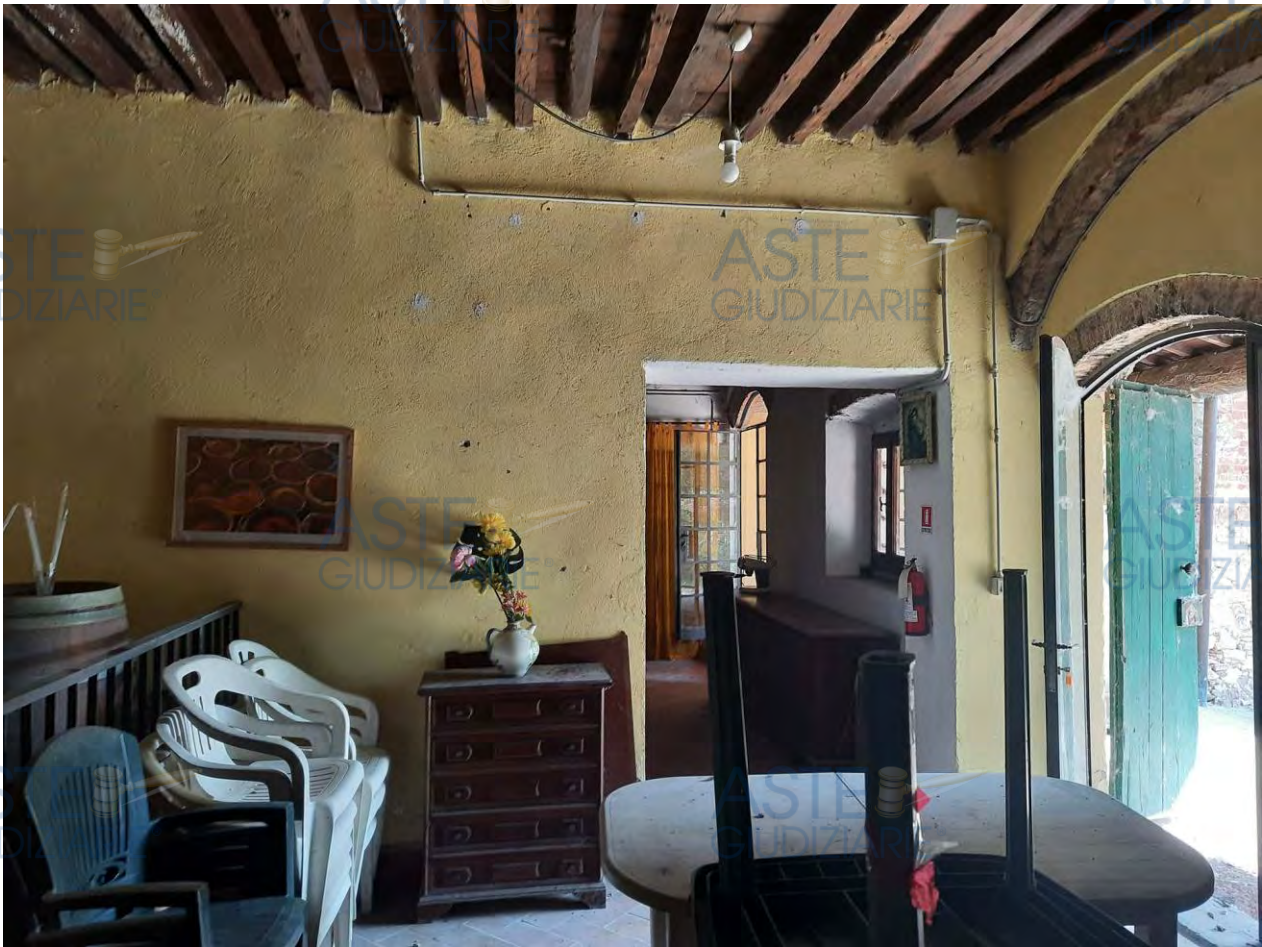
FOTO 36- Una dei locali magazzino/deposito
