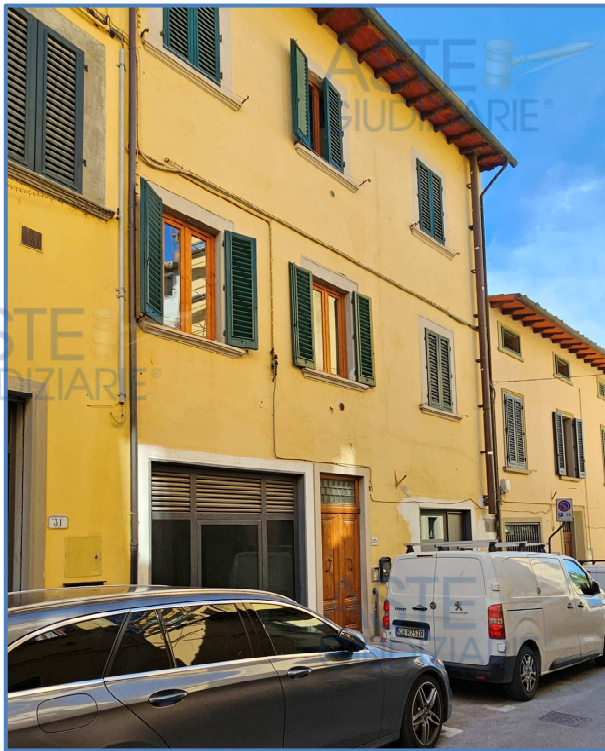
Foto 1- porta d'ingresso a comune all'immobile sito in via Checchi, 35, Fucecchio
