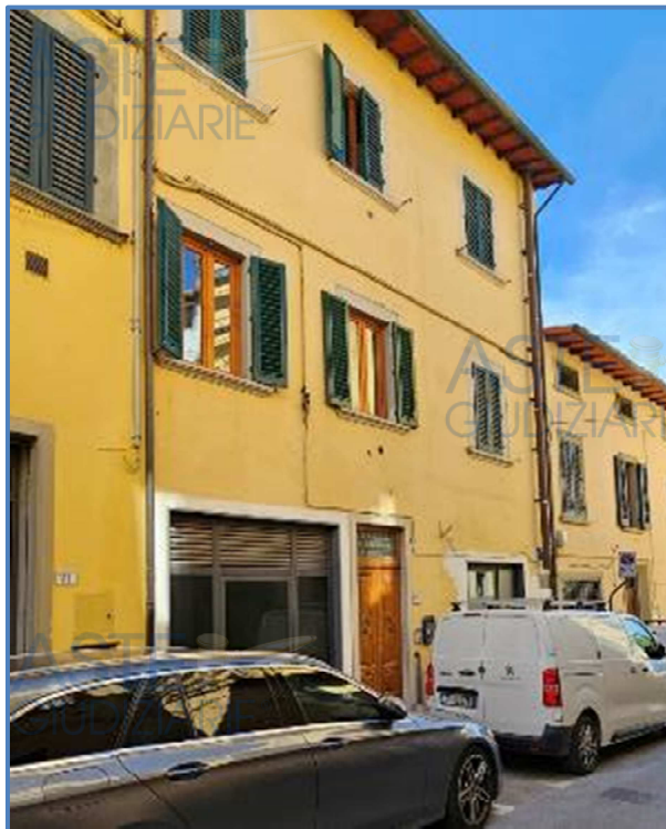
Foto 3- porta d'ingresso a comune all'immobile sito in via Checchi, 35, Fucecchio
