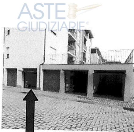
Garage sub 530 –freccia blu
