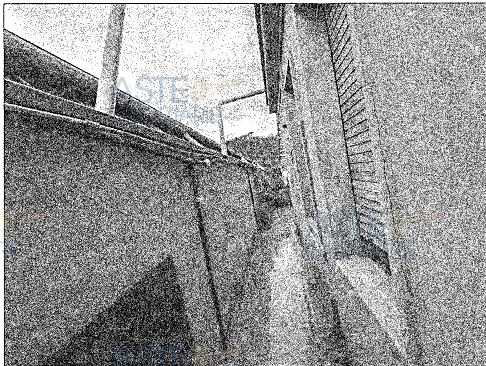
Fotografia 11: Sub. 510 - Corridoio esterno di accesso
