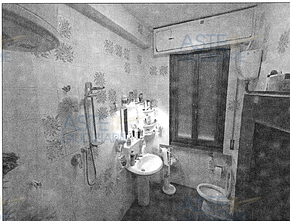
Fotografia 10: Sub. 509 - Servizio igienico
