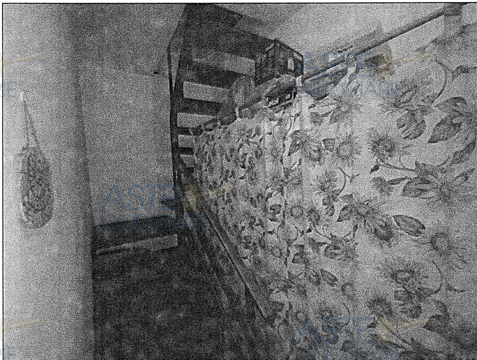
Fotografia 18: Sub. 510 - Scale di collegamento interne
