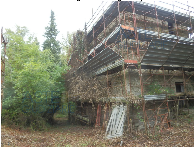
Fabbricato principale - ponteggi e puntellature e vista dall'alto
