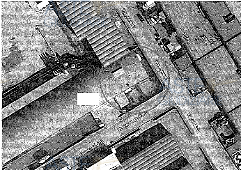
VISTA DEL FABBRICATO
