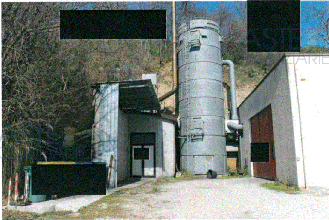
FOTO 5: Silos impianto di aspirazione con locale tecnico
