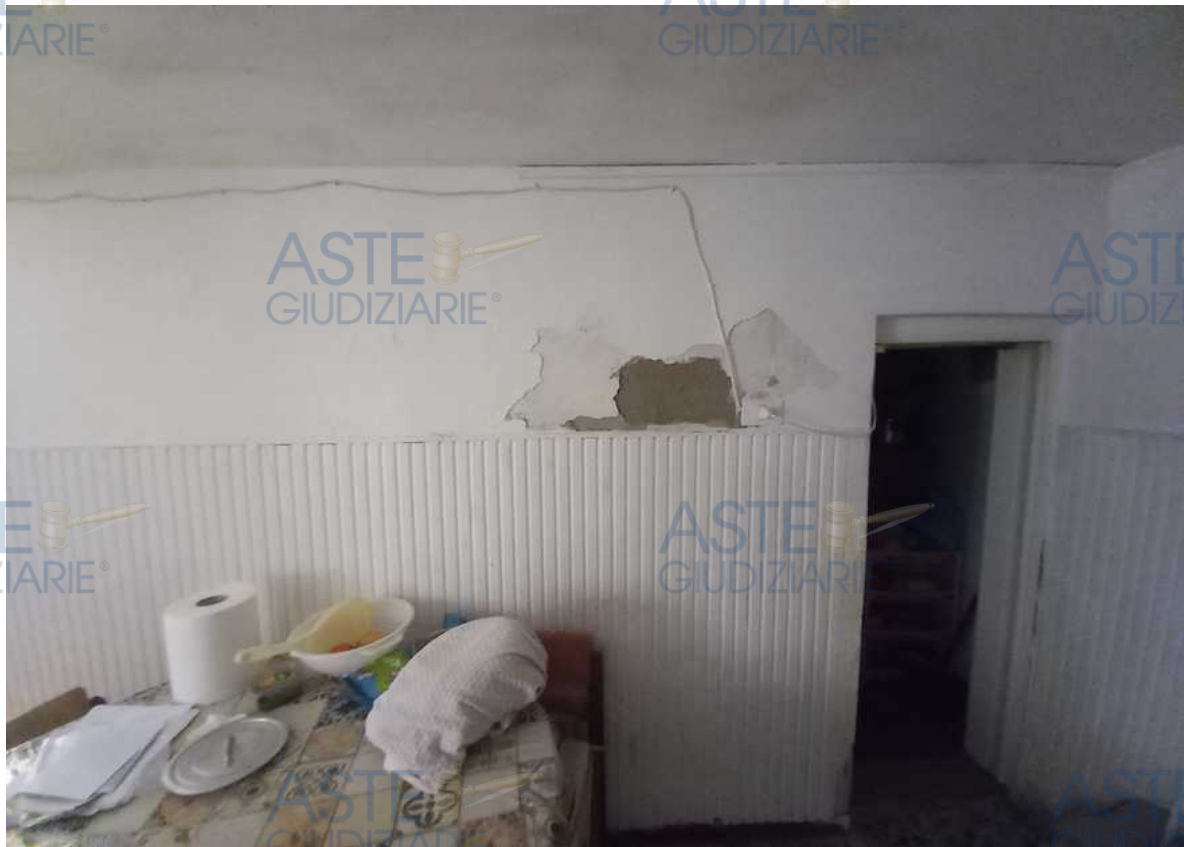
ACCESSO AL SOTTOSCALA DAL RIPOSTIGLIO PIANO TERRA
