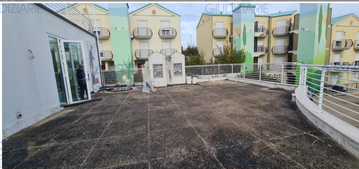
Sopra: lastrico solare esterno esclusivo, compreso nel immobile BAR-RISTORANTE (Sub. 52) al livello primo, con due montacarichi per generi alimentari, palazzina R5
