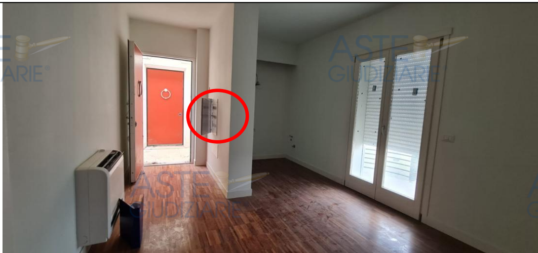
Sotto: bilocale , conformazione e dotazione rappresentativa dell'angolo cucina comune per ogni civile abitazione, con alimentazione dedicata e dimensionata per angolo cottura con fuochi ad induzione, linea e prese elettriche esclusive e scarichi per lavabo
