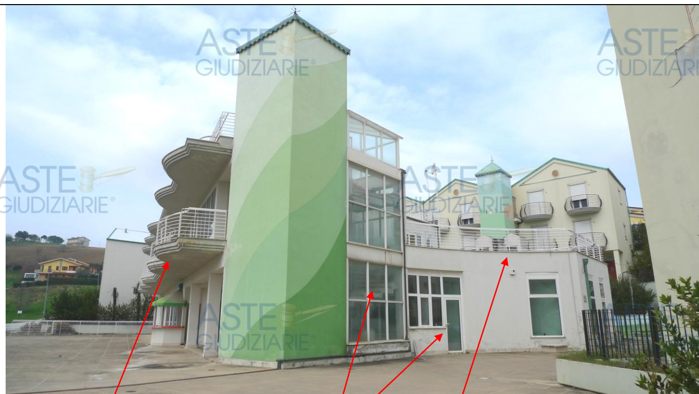
Palazzina servizi R5 a vocazione terziaria/commerciale, vano scala interna finestrata e contiguo vano ascensore, in alto a sinistra con percorso a sbalzo coperto per accesso immobili al P.1, , sulla sinistra piazzetta con edicola (sub.105) antistante alla palazzina, sulla destra accesso al immobile portineria , sopra questa terrazza del locale ristorante (sub. 52)
