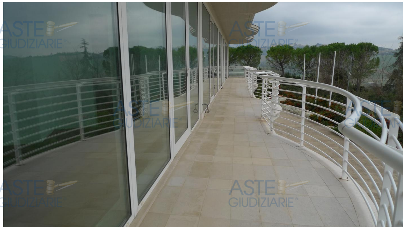
Sopra: Palazzina R5, passerella sbalzo coperta per accesso agli immobili del primo piano
