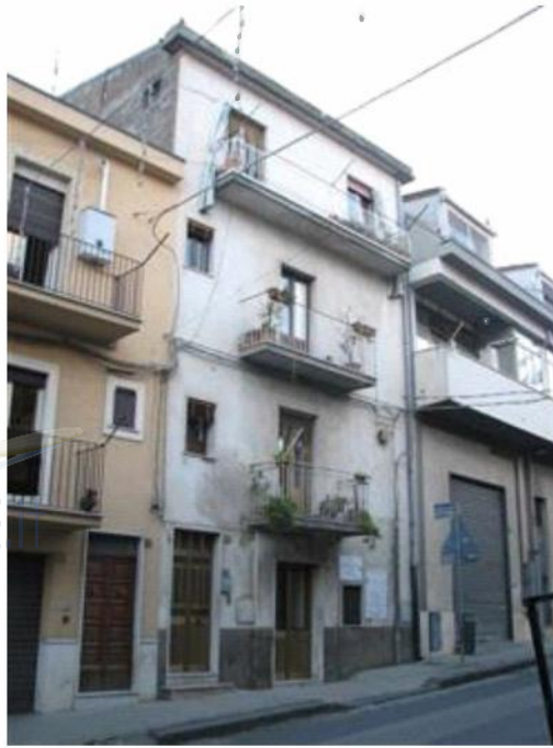
Prospetto principale del fabbricato
