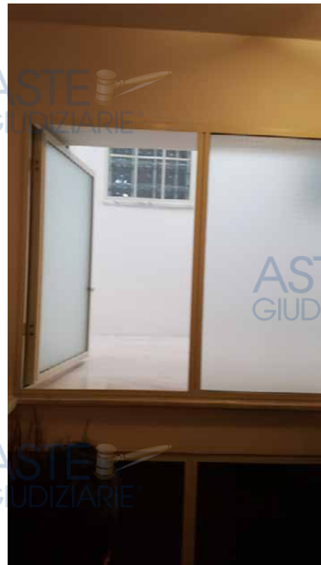
Foto N. 20: Accesso pozzo luce dalla scala comune al Lotto L2-L3 . Lotto L2
