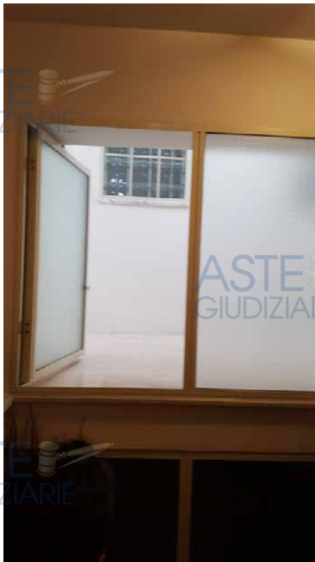
Foto N. 16: Accesso pozzo luce del Lotto L2 dalla scala comune ai Lotti L2-L3
