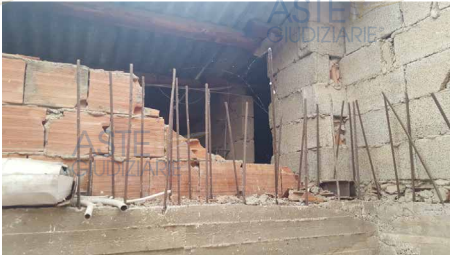
Foto N. 32: Sottotetto. Lotto L3
