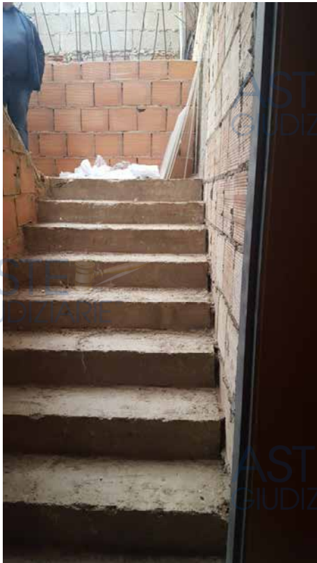
Foto N. 27: Scala di accesso al sottotetto dal Vano n. 2. Prima Rampa. Lotto L3
