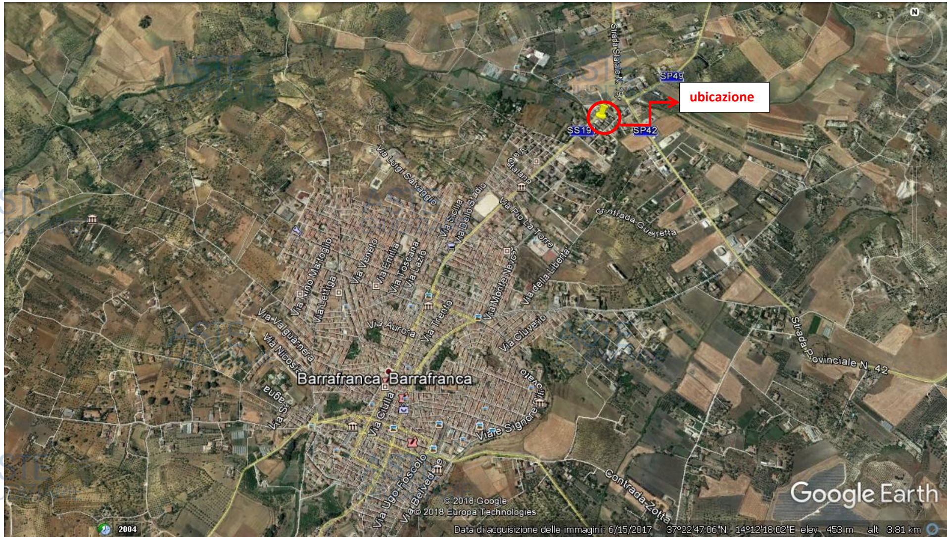
FO- SA- L1-L2-L3-L4- N.1/6 FABBRICATI IN VIALE GENERALE CANNADA E VIA DELLE ROSE - VISTA DALL'ALTO
