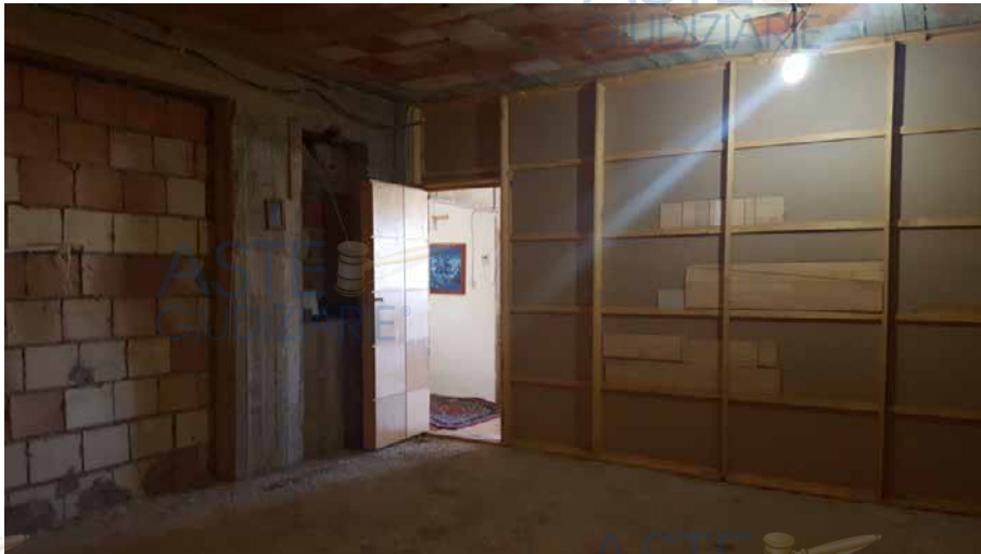
Foto N. 24: Parete divisoria e porta tra Vano 1 e Vano n. 2. Piano Primo Lotto L3
