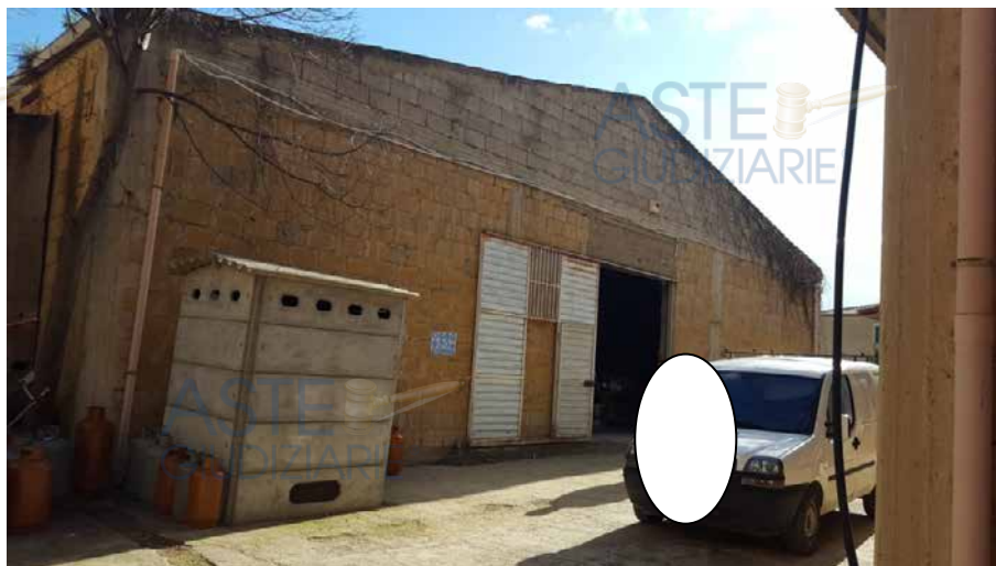
Foto N. 6: Prospetto posteriore visto dalla corte interna al lotto L4
