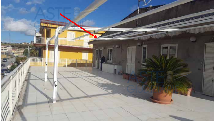
Foto N. 7: Vista Del Terrazzo- Lotto L2-L3
