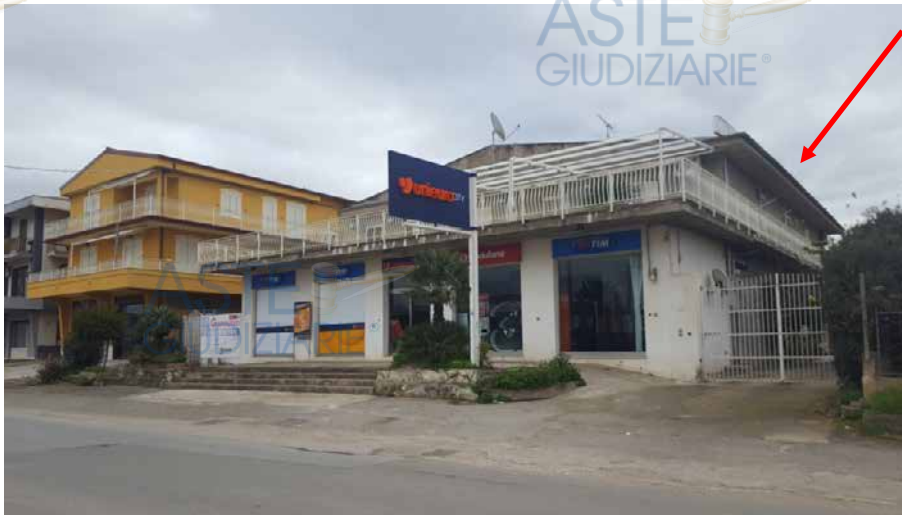
Foto N. 1: Vista Dalla Via G. Cannada Piano Primo Lotto L2
