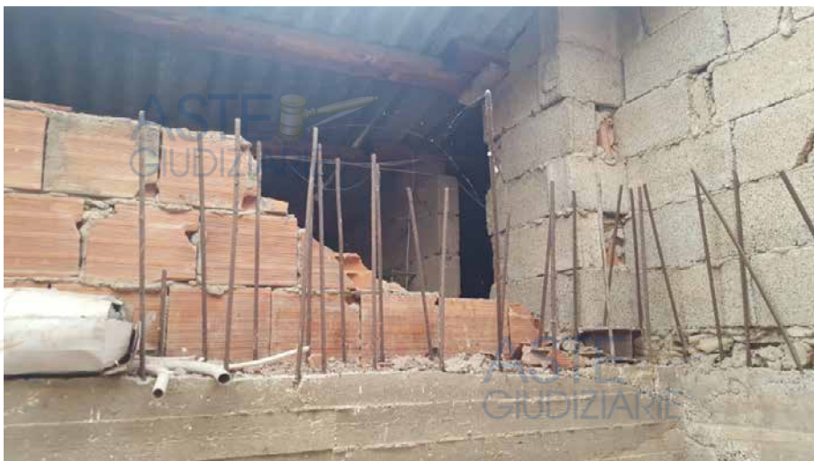
Foto N. 31: Sottotetto. Lotto L3
