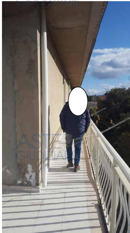
Foto N. 14: Vista Balcone - Lotto L2
