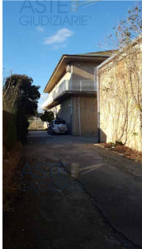
Foto N. 11: Vista Posteriore Lotto 1 dalla Corte del lotto L4
