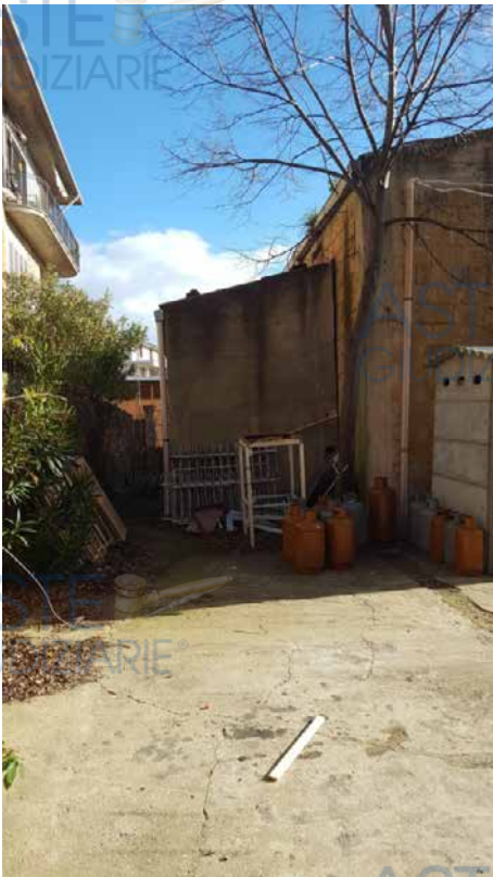
Foto N. 13: Locale Idrico da demolire Lotto L4
