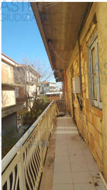
Foto N. 11: Vista Del Balcone Posteriore- Lotto L3
