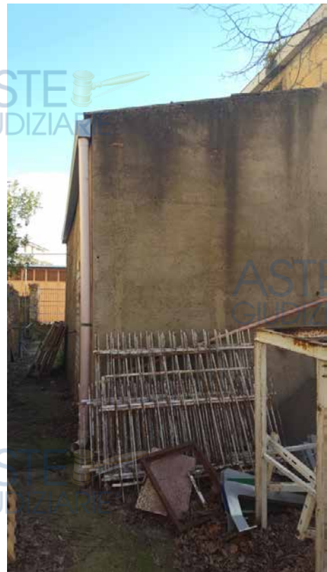
Foto N. 12: Locale idrico da demolire Lotto L4
