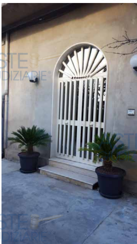
Foto N. 12: Ingresso Comune ai lotti L2-L3 visto dalla Corte comune ai lotti L1-L2- L3. Lotto L3
