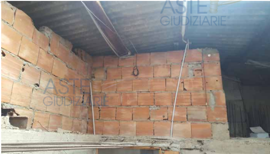
Foto N. 29: Sottotetto. Lotto L3
