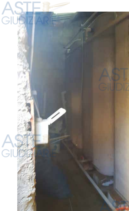
Foto N. 5: Vasche Idriche all'interno del locale idrico da demolire - Lotto L4
