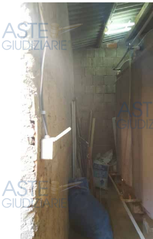
Foto N. 7: Locale idrico da demolire Lotto L4
