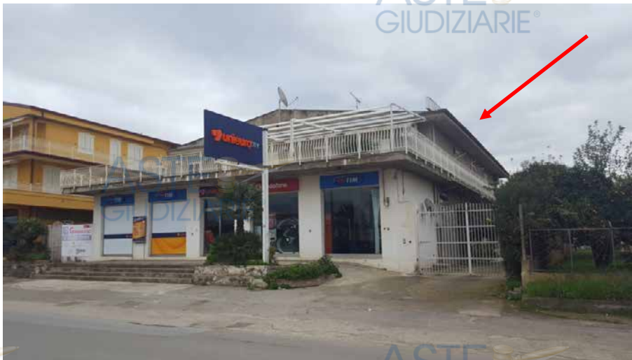
Foto N. 2: Vista Dalla Via G. Cannada- Piano Primo Lotto L2
