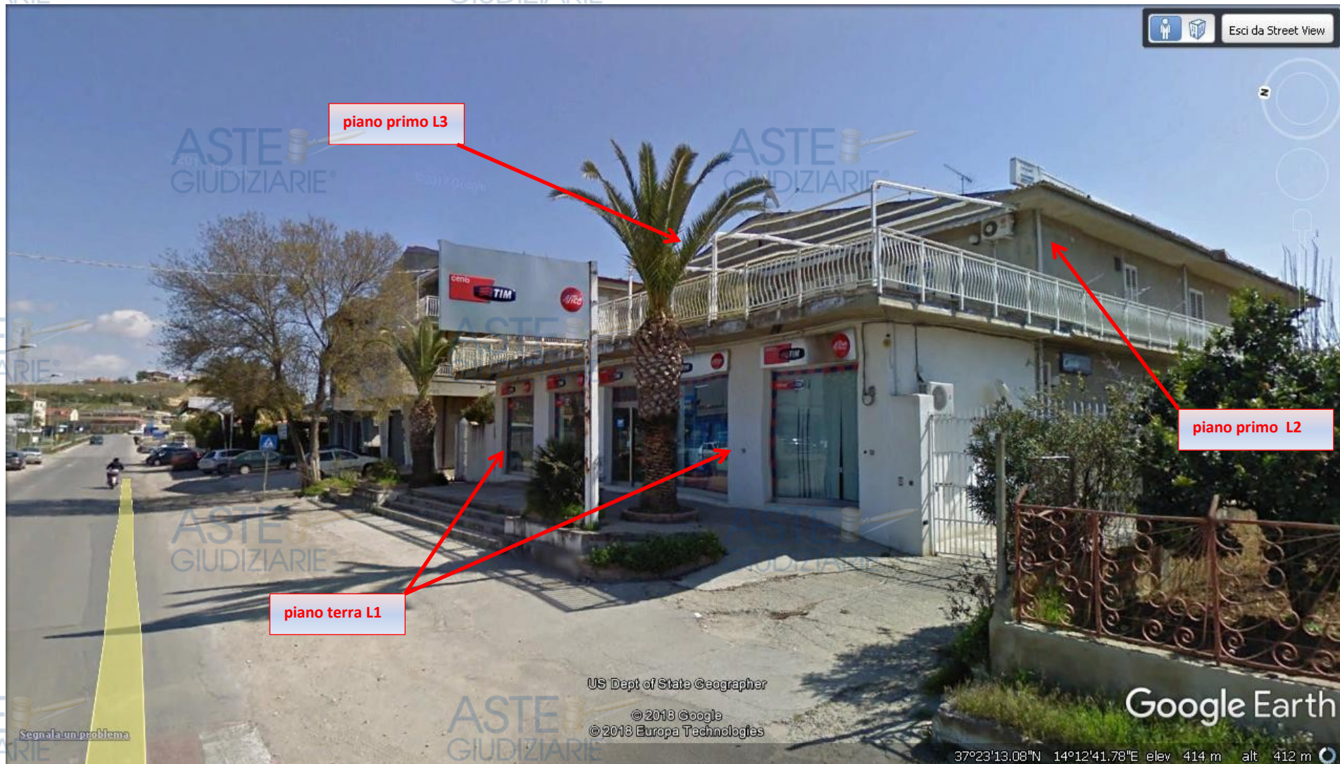
FO- SA- L4- N.4/6 FABBRICATO IN VIA DELLE ROSE -L1-L2-L3 - VISTA DALLA STRADA- PUNTO DI RIPRESA 1
