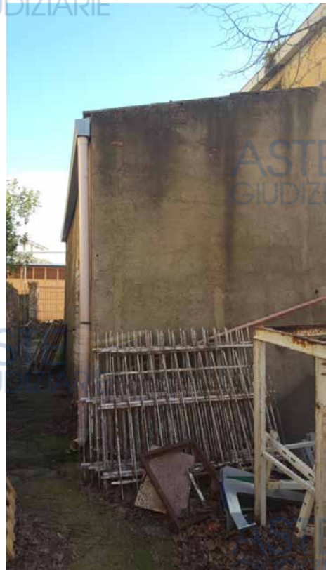
Foto N. 2: Locale Idrico da demolire Lotto L4
