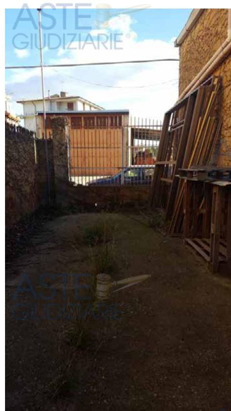
Foto N. 5: cancello sinistro di accesso visto dalla corte interna Lotto L4
