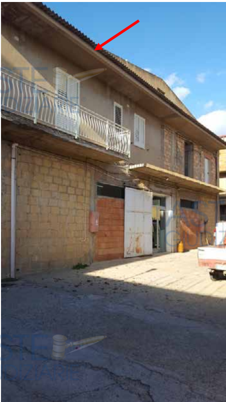
Foto N. 8: Vista Posteriore Dalla Corte comune Lotto L2
