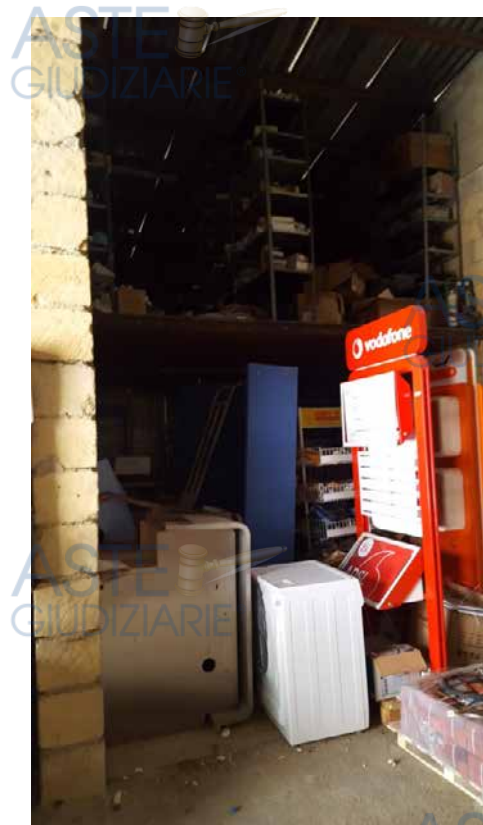
Foto N. 21: Interno del magazzino e controsoffitto Lotto L4
