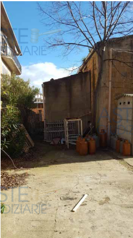
Foto N. 3: Locale Idrico da demolire Lotto L4
