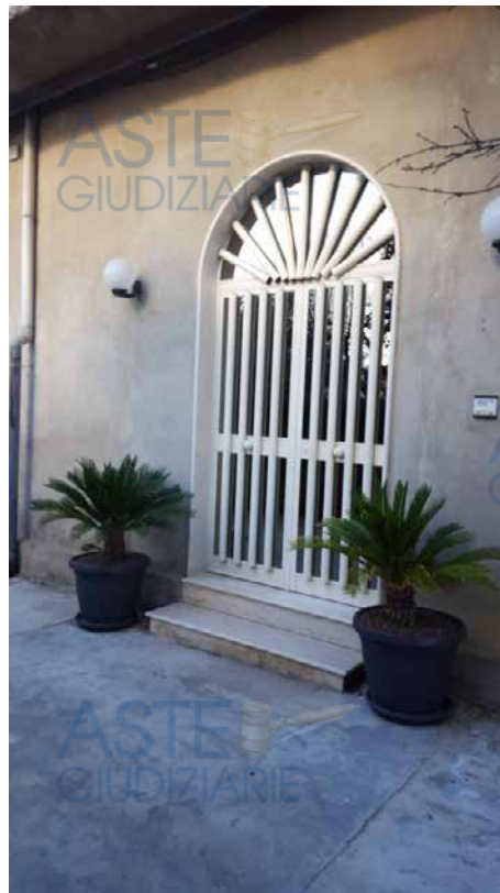
Foto N. 16: Ingresso Dalla Corte Lotto L2
