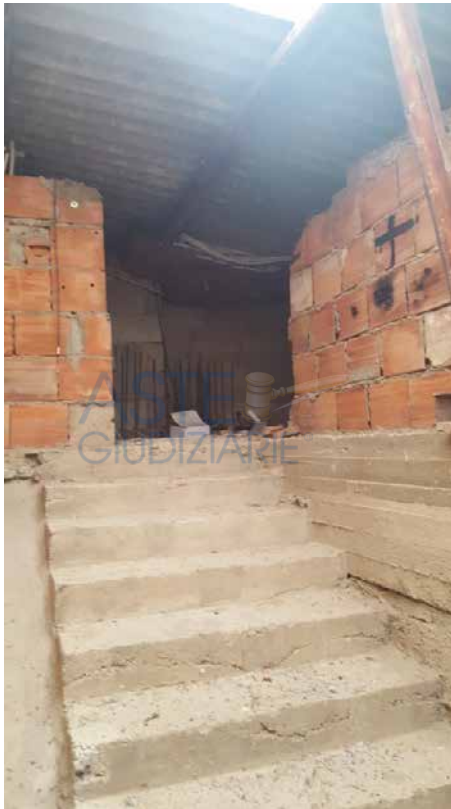
Foto N. 28: Scala di accesso al sottotetto dal Vano n. 2. Seconda Rampa. Lotto L3
