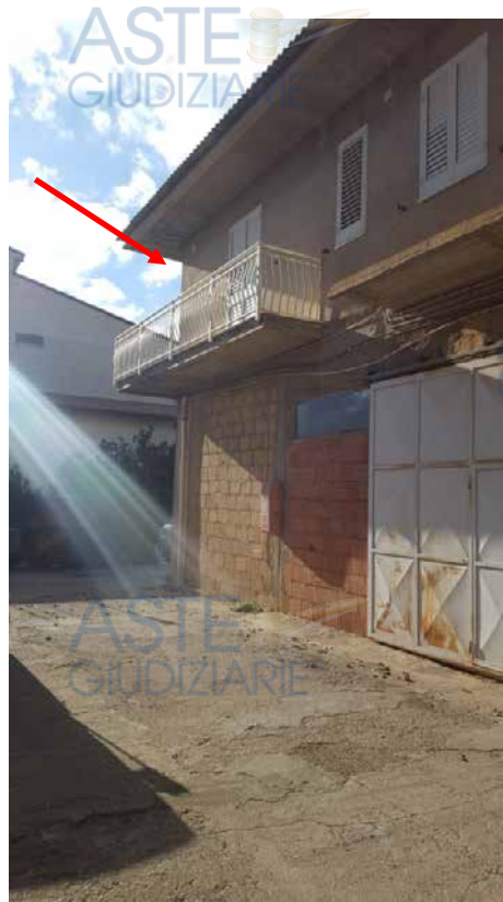
Foto N. 7: Vista Posteriore dalla Corte Comune Lotto L2
