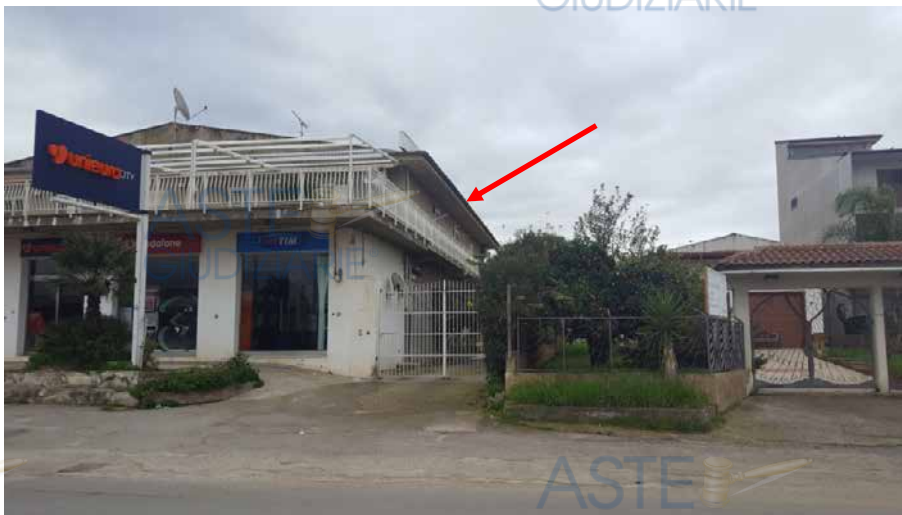
Foto N. 3: Vista Dalla Via G. Cannada. Piano Primo Lotto L2
