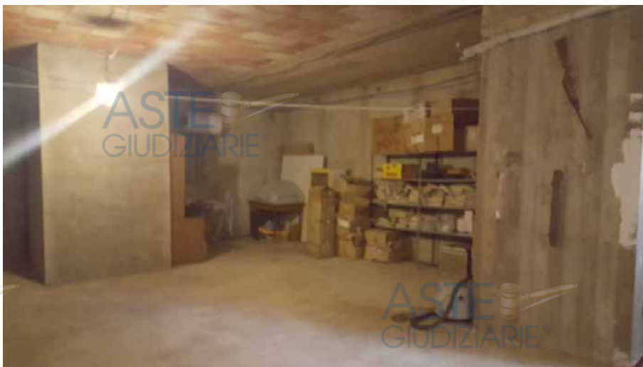
Foto N. 25: Vano n. 2. Piano Primo Lotto L3
