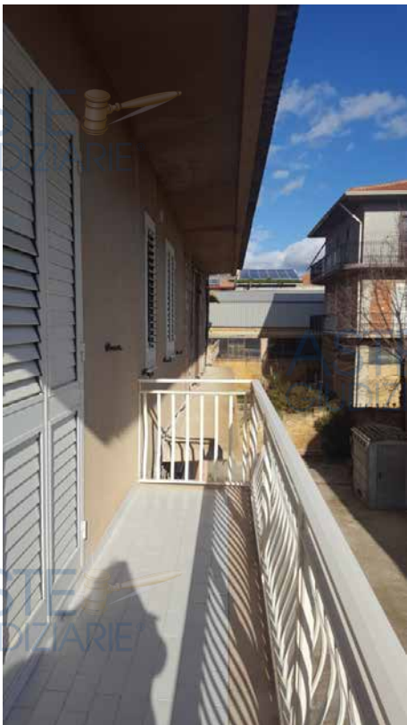
Foto N. 15: Vista Balcone dal Terrazzo- Lotto L2
