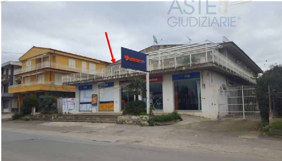
Foto N. 1: Vista Dalla Via G. Cannada Piano Primo Lotti L3
