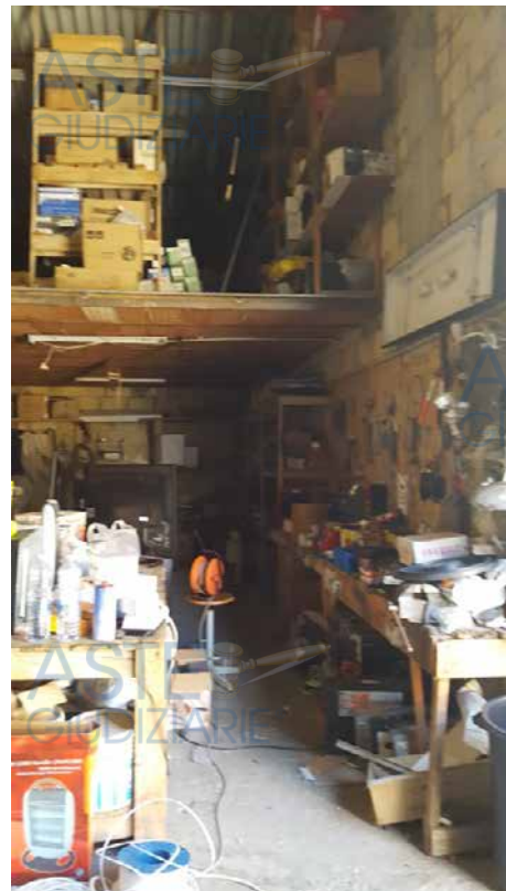
Foto N. 19: Interno del magazzino e controsoffitto Lotto L4
