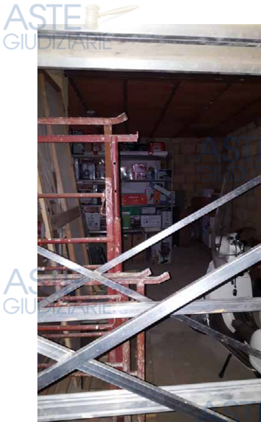
Foto N. 32: Interno del magazzino e controsoffitto Lotto L4
