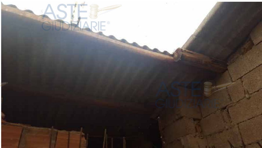
Foto N. 33: Vista del Lucernario di copertura dal sottotetto. Lotto L3
