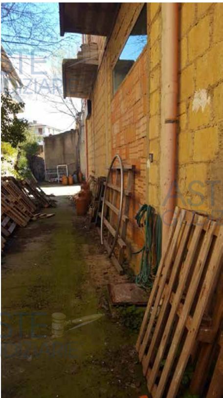
Foto N. 11: Locale idrico da demolire visto dalla corte interna dei lotti L1-L2-L3-Lotto L4
