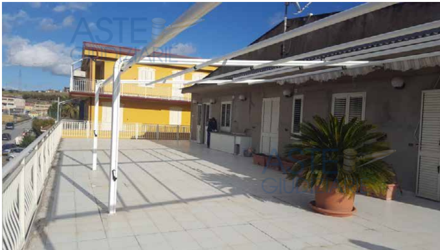
Foto N. 11: Vista Del Terrazzo- Lotto L2
