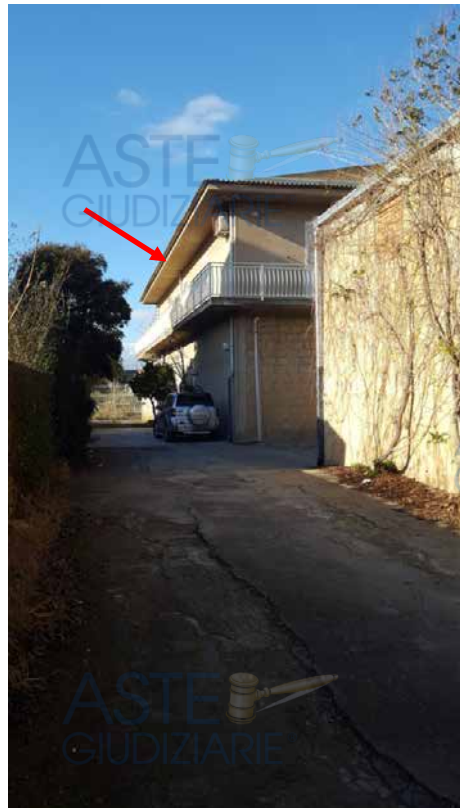
Foto N. 9: Vista Posteriore Dalla Corte esclusiva del lotto L4 a
