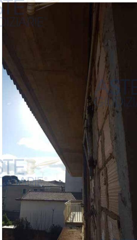
Foto N. 10: Vista Del Balcone Posteriore- Lotto L3
