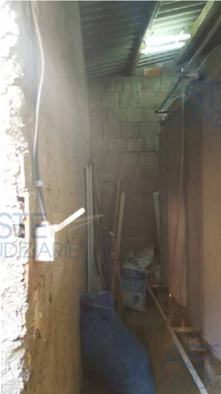
Foto N. 16: Locale idrico da demolire Lotto L4
