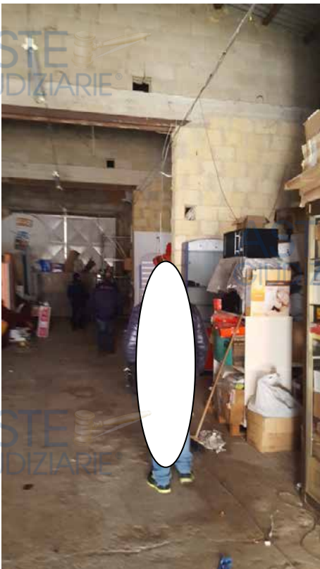
Foto N. 18: Interno del magazzino Lotto L4
