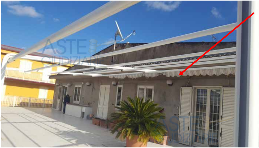
Foto N. 10: Vista Del Terrazzo- Lotto L2
