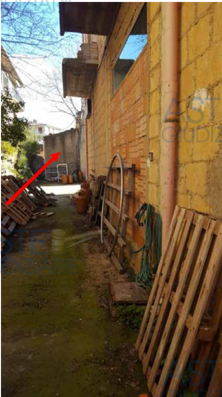
Foto N. 1: Locale idrico da demolire visto dalla corte interna dei lotti L2-L3
