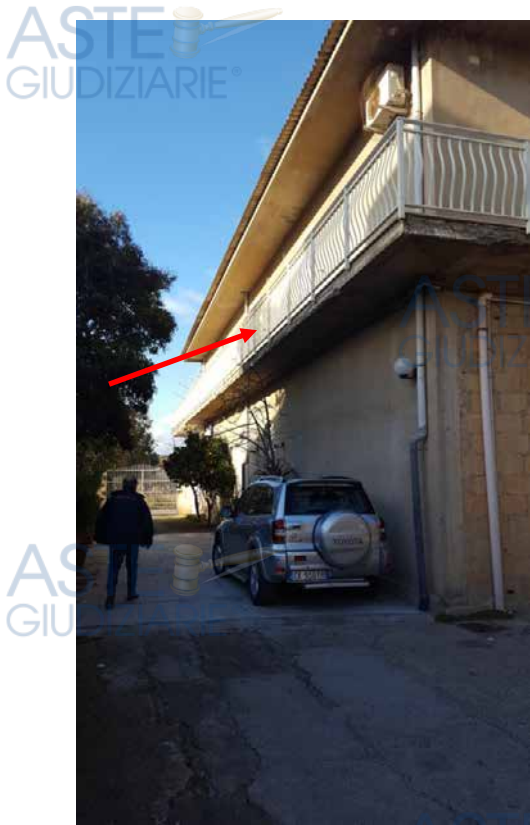
Foto N. 6: Vista Laterale Dalla Corte Comune Lotto L2
