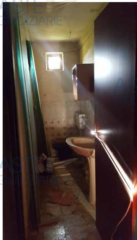
Foto N. 39: Wc del magazzino Lotto L4
