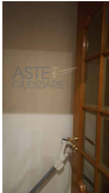
Foto N. 29: finitura della porta del ripostiglio 1 Lotto L2
