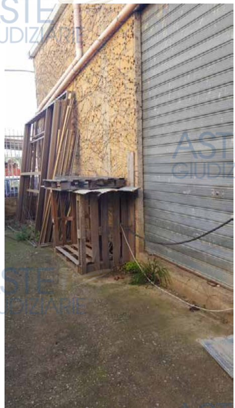
Foto N. 10: Ingresso laterale visto dalla corte interna da murare lotto L4
