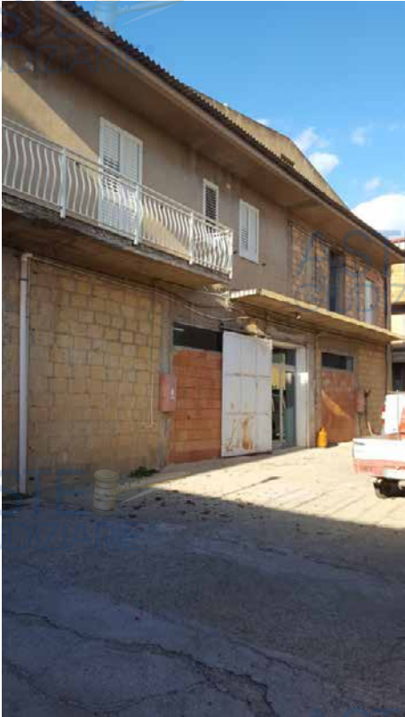
Foto N. 10: Vista Posteriore Dalla Corte piano terra Lotto L1
