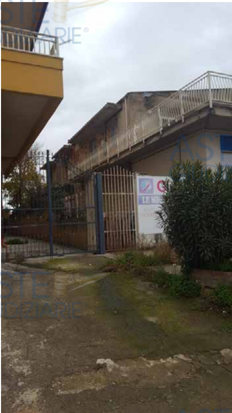
Foto N. 6: Vista dalla Via G. Cannada. Piano terra lotto L1
