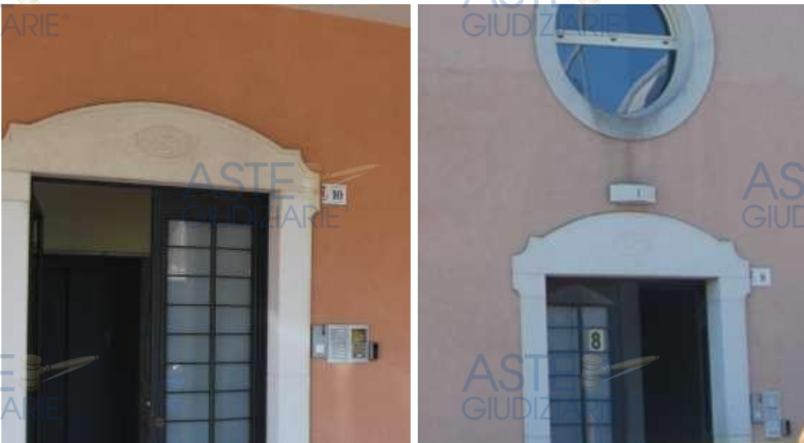
Foto 1. Corpo Scala “A” e Corpo Scala “B”
