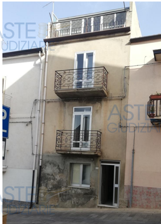
Fabbricato oggetto di pignoramento
