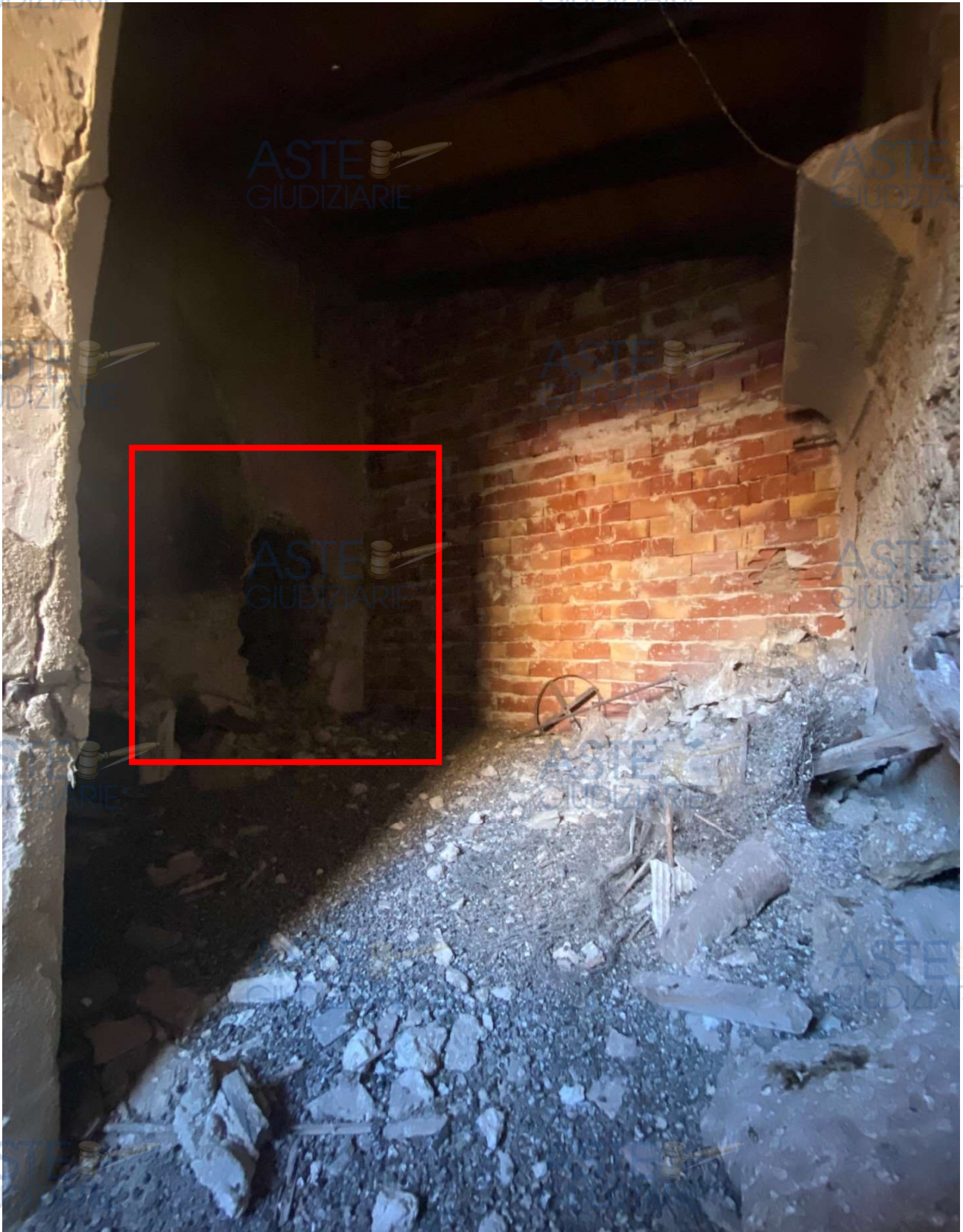
Sbarramento fisico al prosieguo delle operazioni peritali nel piano secondo
