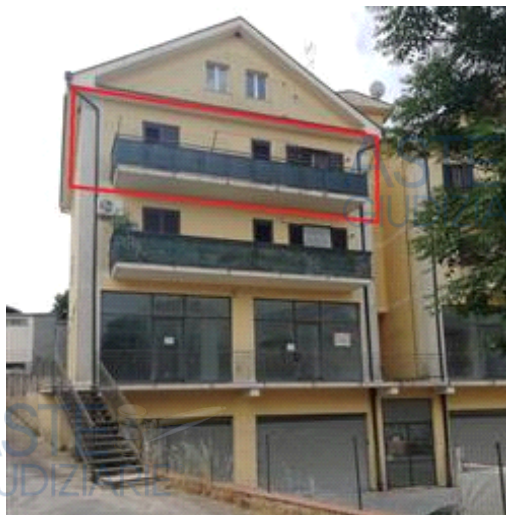
Prospetto principale del fabbricato con in evidenza l'alloggio pignorato
