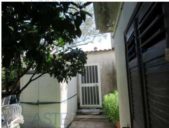
VISTE ETERNE LATO CUCINA E LOCALE DEPOSITO
