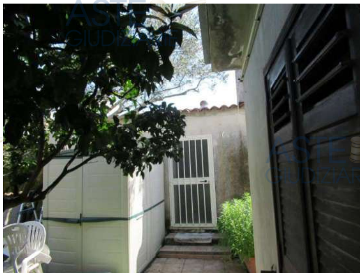
VISTE ETERNE LATO CUCINA E LOCALE DEPOSITO
