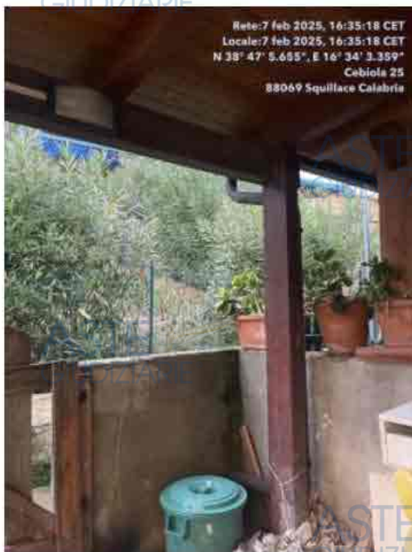
Foto 17. Ingresso secondario e tettoia in legno (retro)
