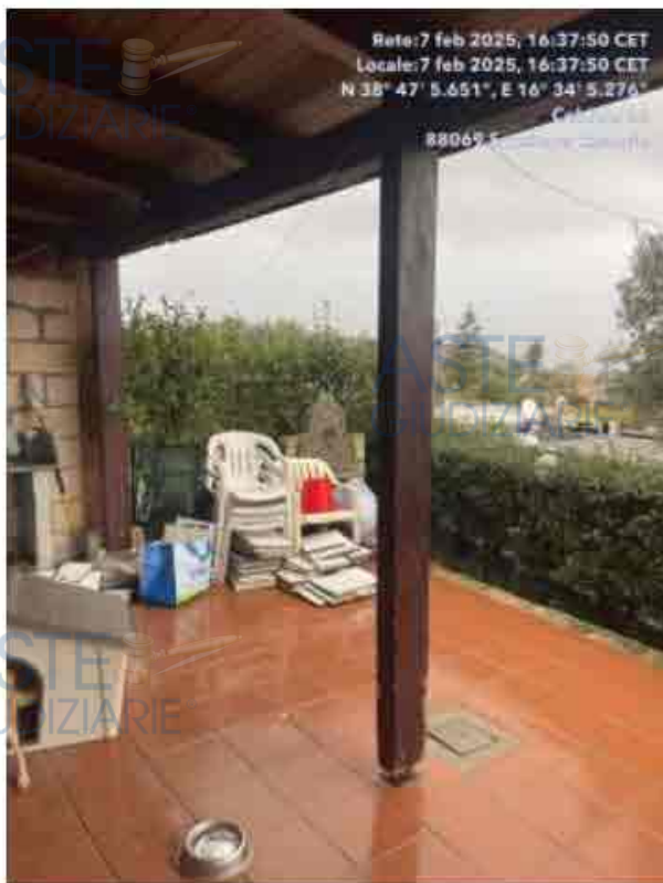
Foto 3. Tettoia esterna in legno
