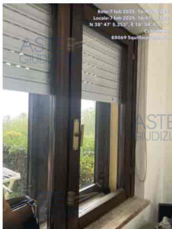
Foto 6. Particolare finestra ingresso-soggiorno
