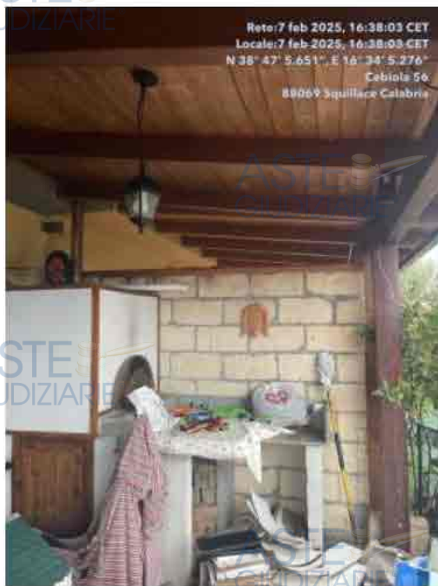
Foto 1. Tettoia esterna in legno
