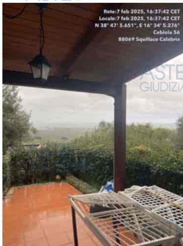
Foto 2. Tettoia esterna in legno
