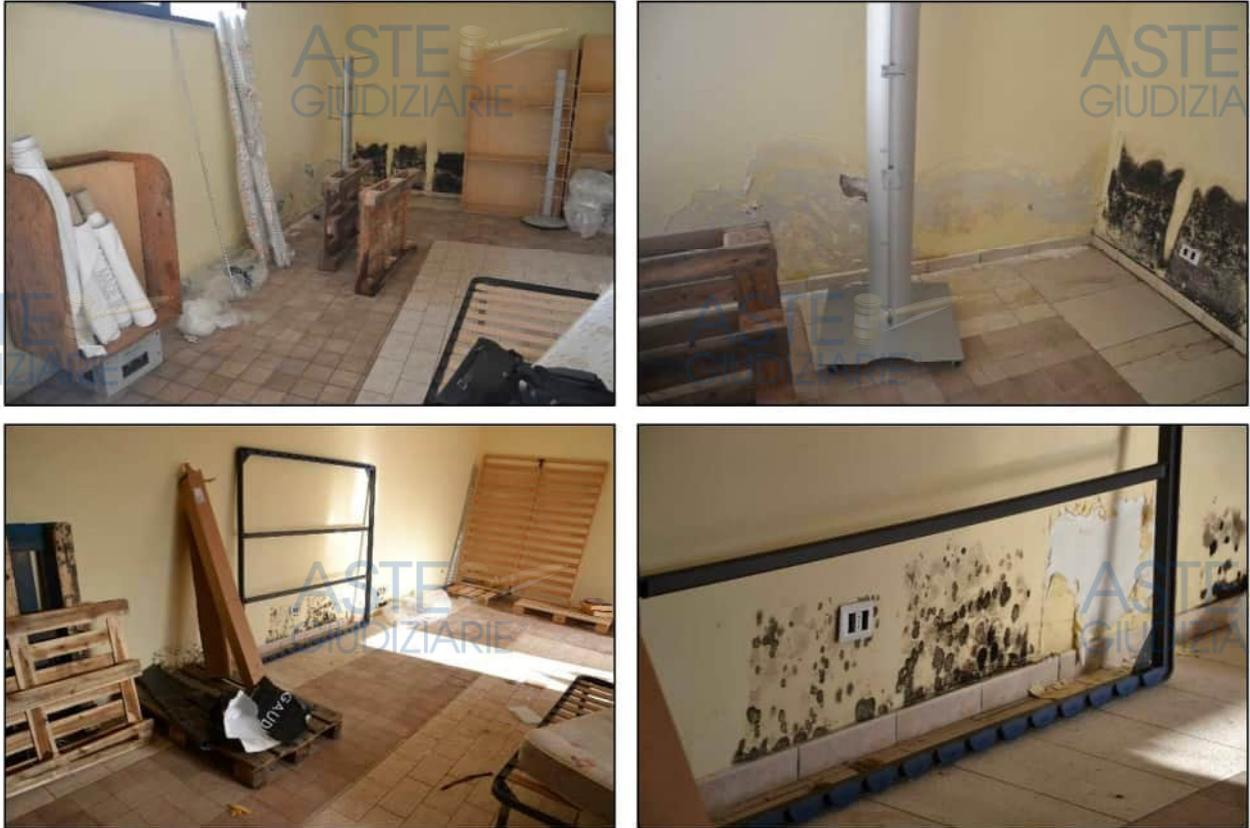
Figura 17 - Deterioramento delle finiture a causa delle infiltrazioni nel DEPOSITO 1
