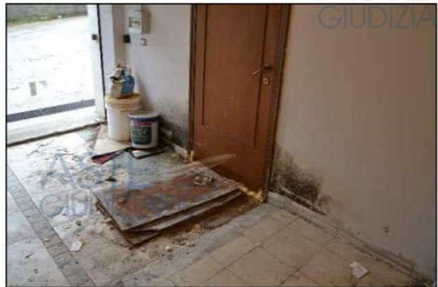
Figura 19 - Deterioramento delle finiture a causa delle infiltrazioni nel DEPOSITO 2
