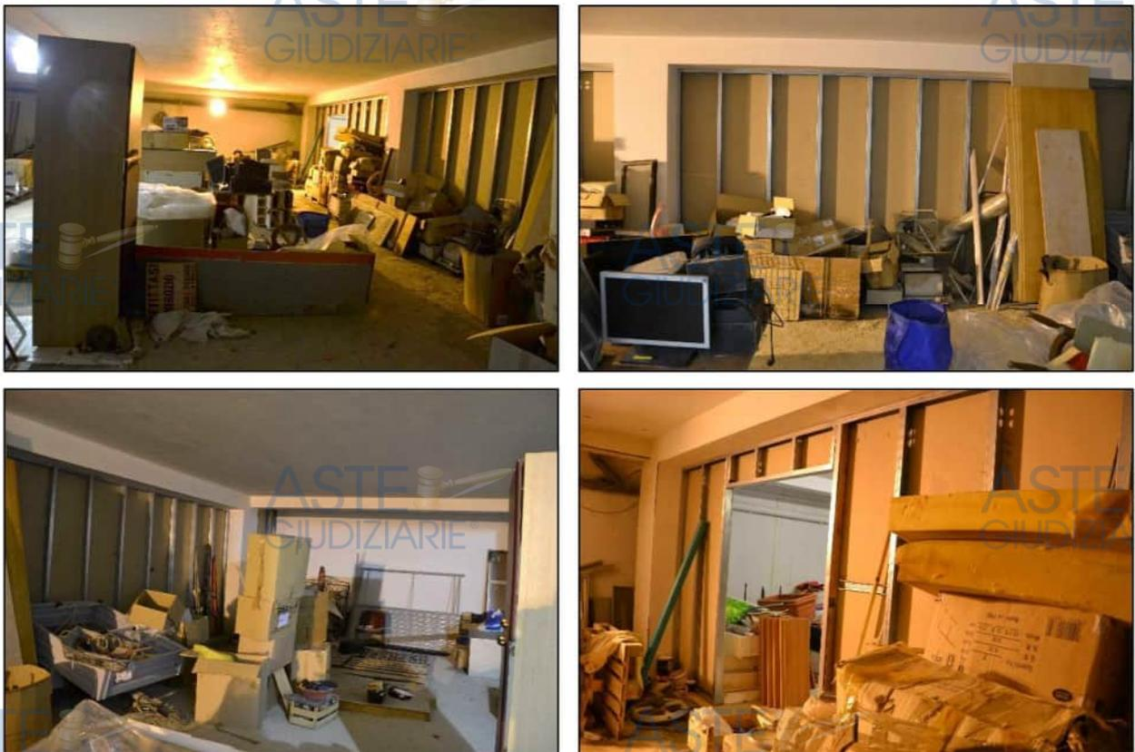
Figura 22 – Tramezzature in cartongesso incomplete
