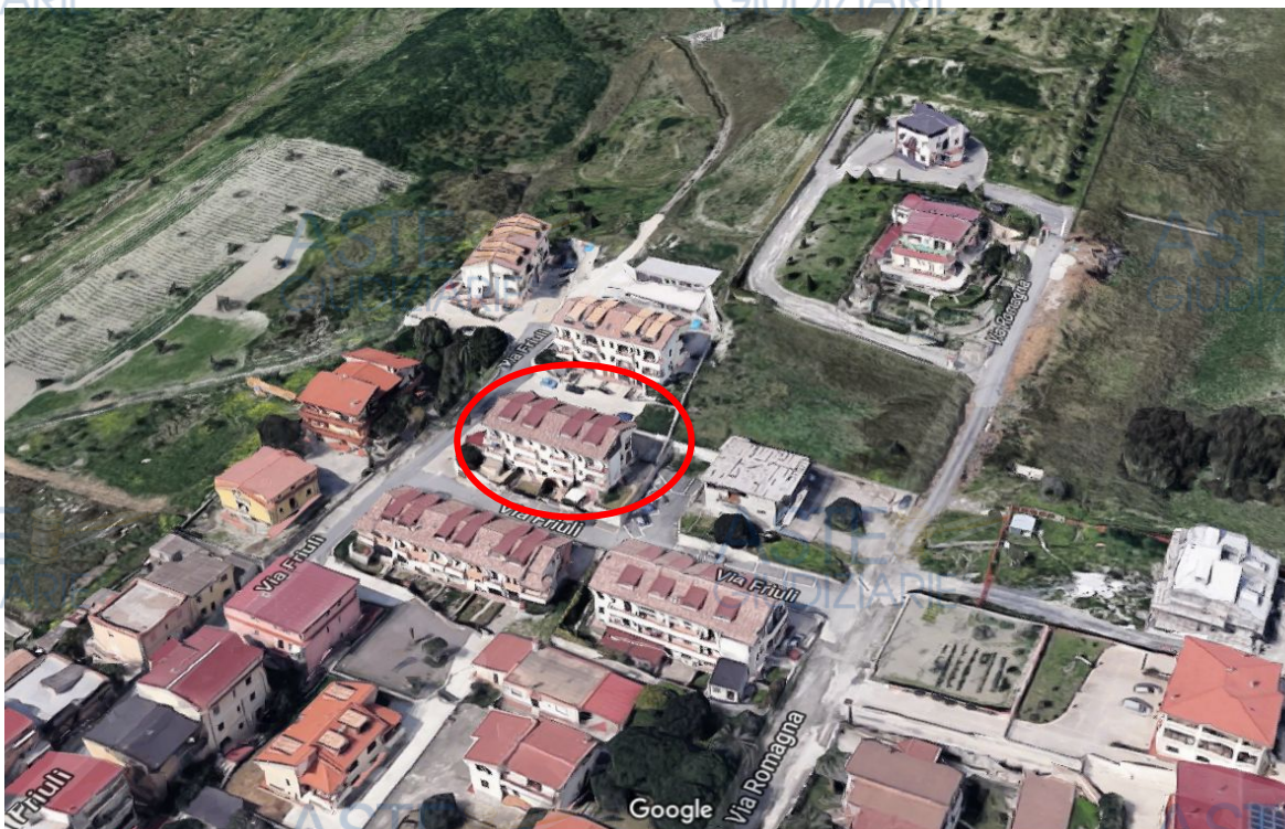
Fig. 2: Vista aerea del fabbricato "B" Foto tratta da Google Maps
