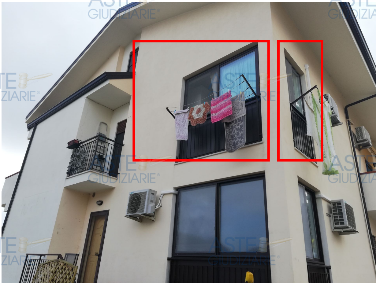
Foto 10: Prospetto Nord-Est fotografato durante il sopralluogo del 2 ottobre 2020
