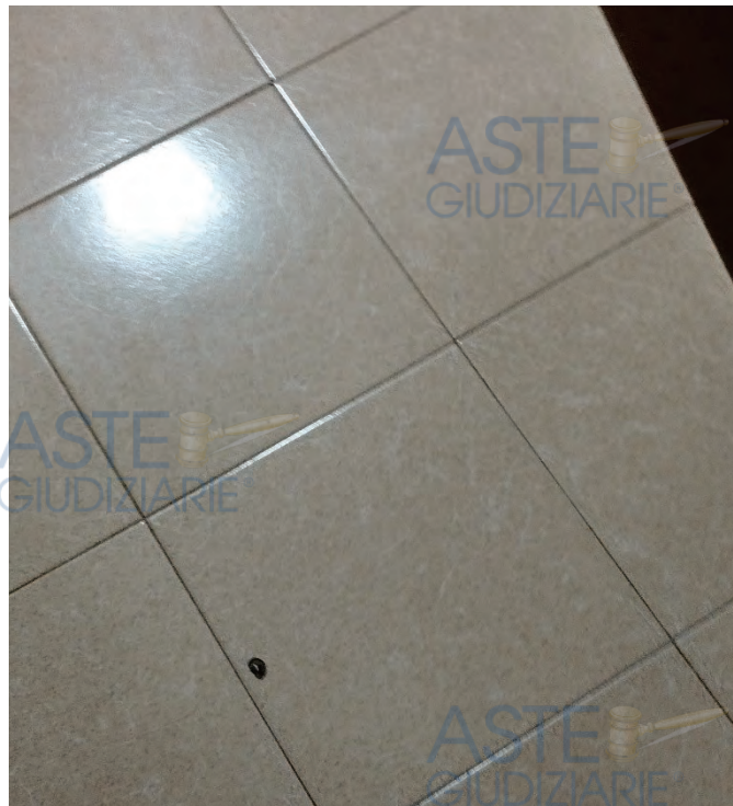
Fig. 8 – Pavimentazione gres porcellanato
