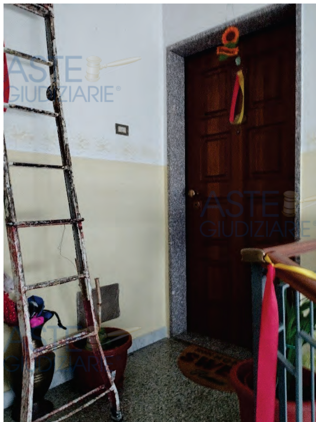
Fig. 3 – Portone d'ingresso condominiale
