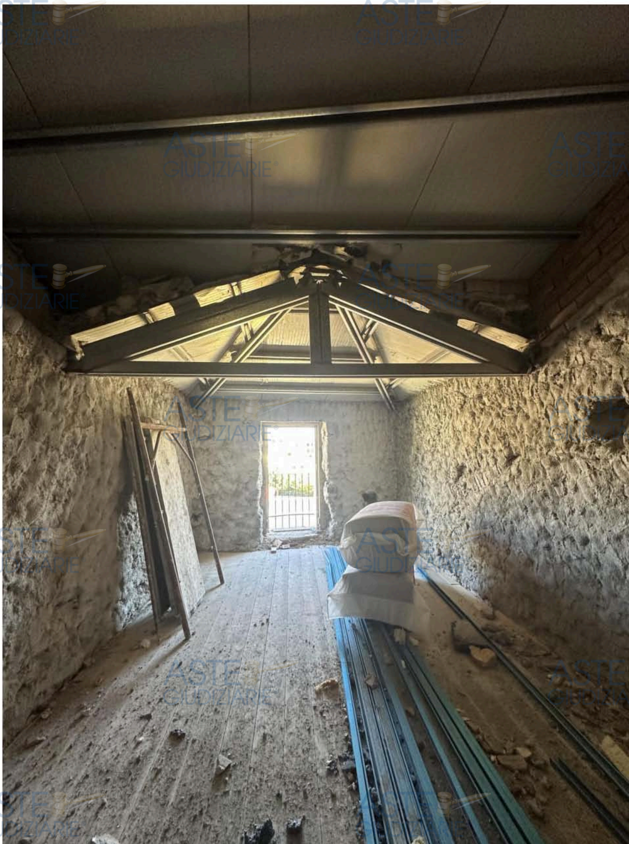
Foto 12: Vista secondo vano piano primo
