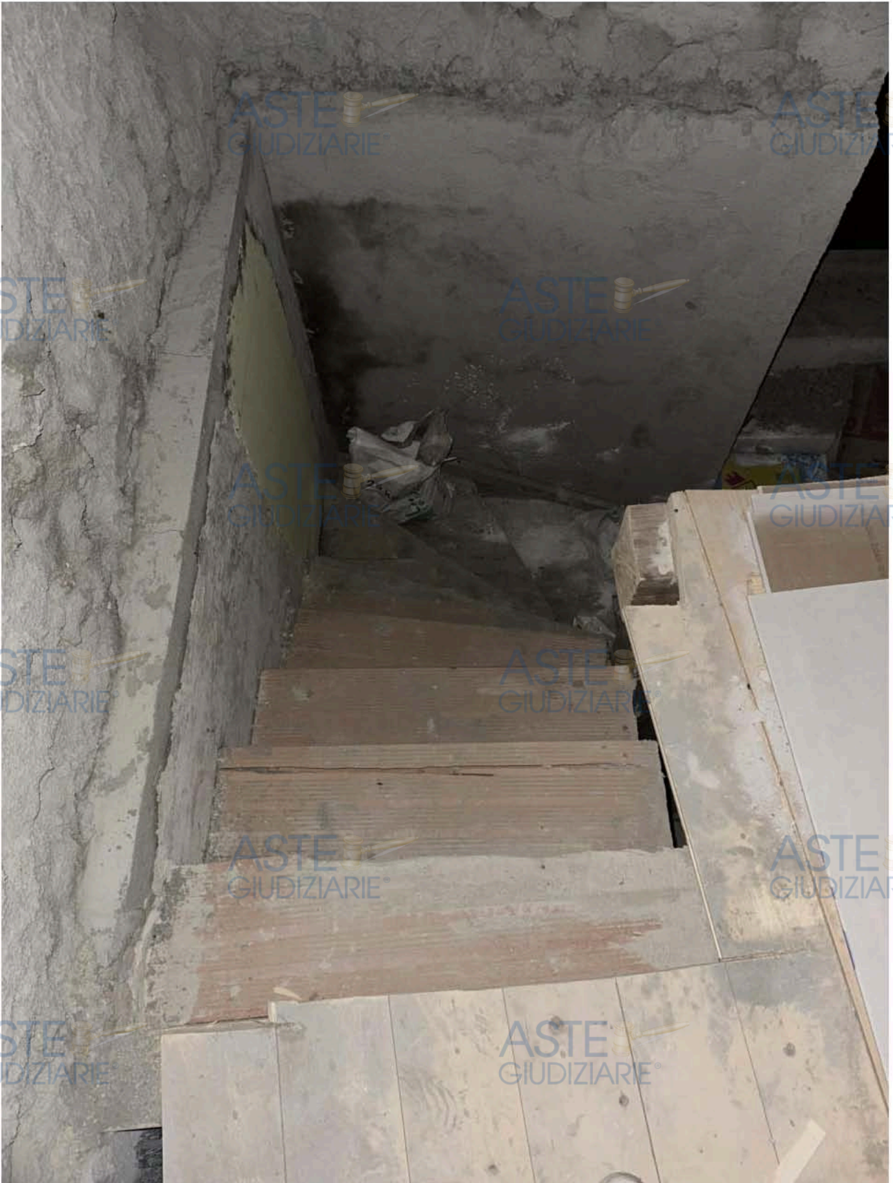
Foto 9: Vista scala vano piano terra
