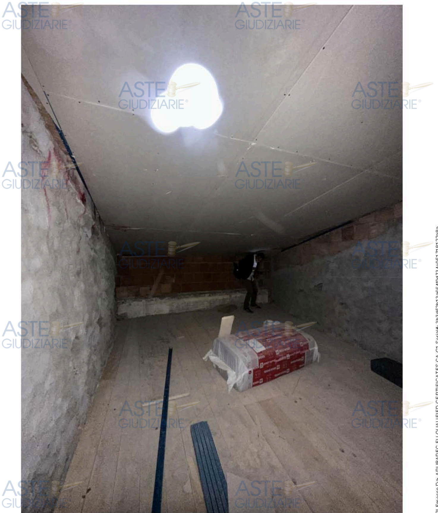
Foto 11: Vista vano soffitta piano primo
