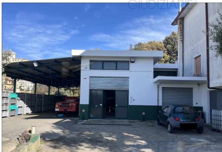
Fig. 9– FOTO FABBRICATO – PIANO TERRA
