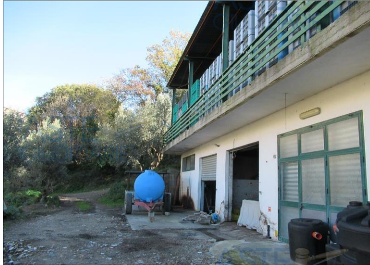
Fig. 11 – FOTO FABBRICATO – Piano seminterrato
