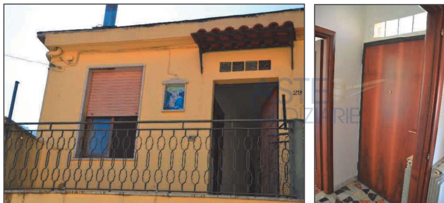
Figura 10 - Portoncino di ingresso
