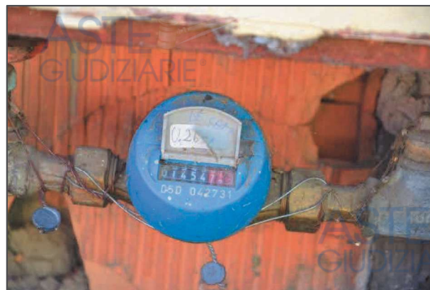
Figura 16 - Contatore idrico
