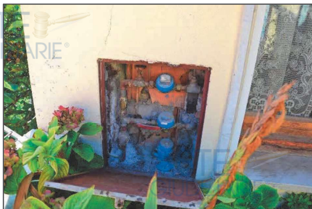
Figura 16 - Contatore idrico
