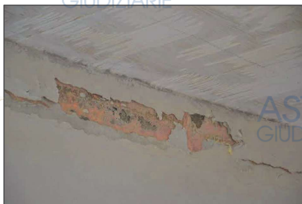
Figura 11 – Deterioramento delle finiture interne
