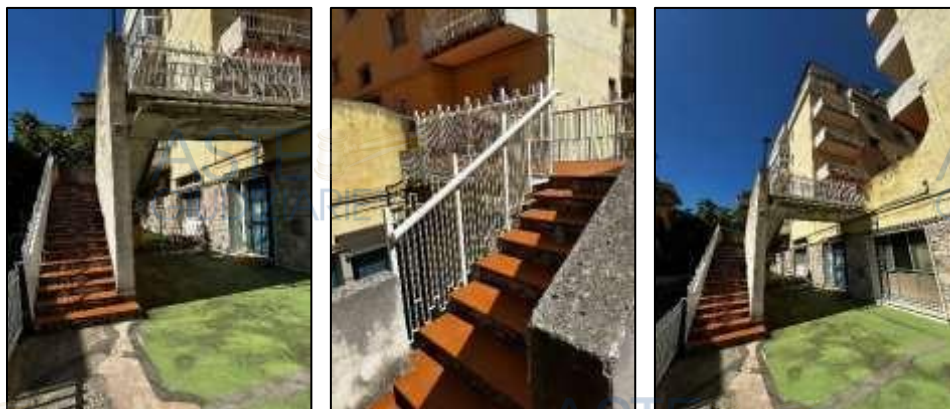
Figura 23 - Rampa pedonale – foglio 64, particella 107
