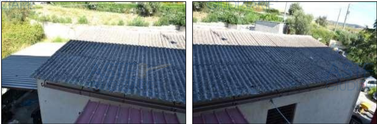
Figura 54 - Copertura in lastre di eternit fabbricato individuato dalle particelle 367-368
